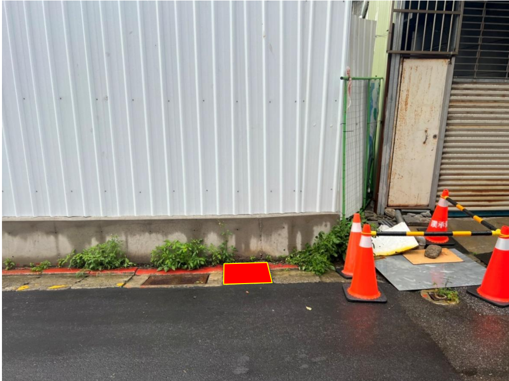
照片 1：北投區明德路 203-5 號前道路現況
