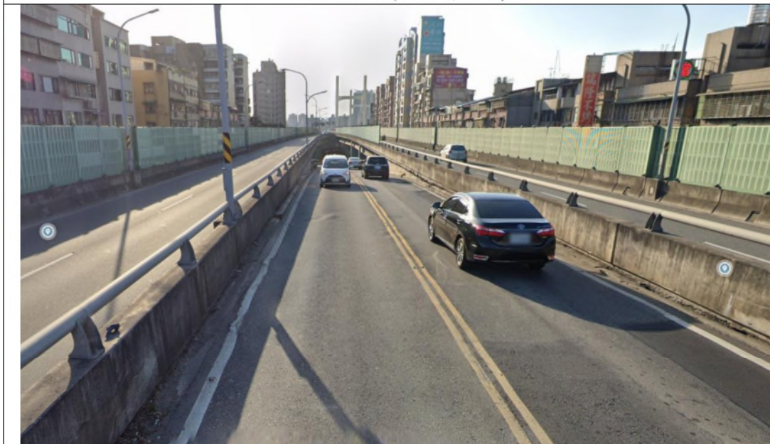
重陽橋引道(往環河北路)
