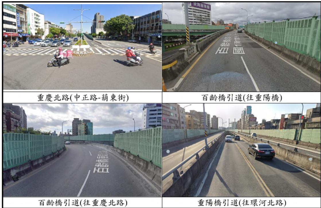
圖 2.1-3 工區周邊道路現況
