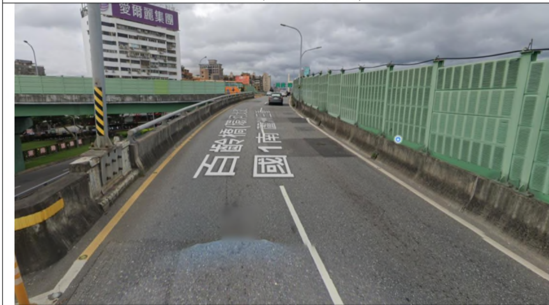
百齡橋引道(往重陽橋)
