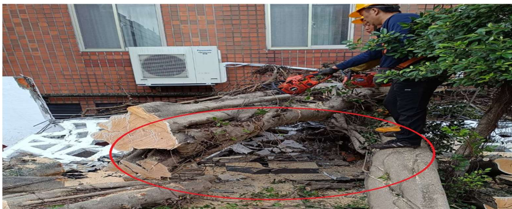
照片1說明：臺北市立大學圍牆倒塌，導致文廟舊址碑毀損。
