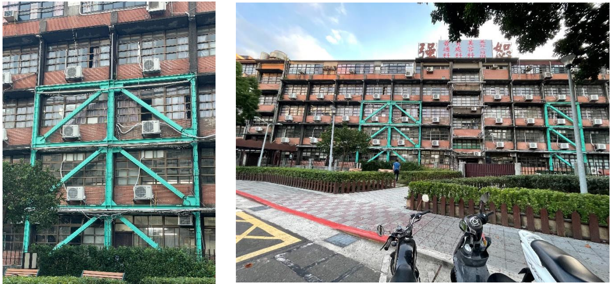
圖 3.14 外置鋼框架+斜撐於強恕中學補強工程應用
