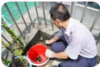
積極防颱 - 屋頂排水孔疏通
