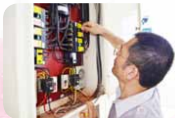
水電醫生 - 修理電器
