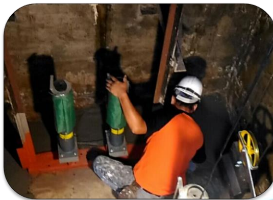
6號、7號電梯更換工程
