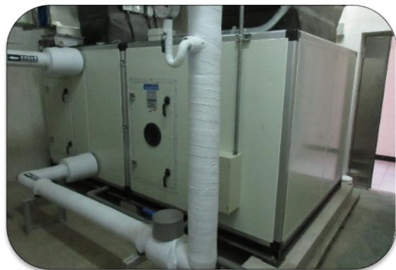
1樓及5樓空調系統改善工程
