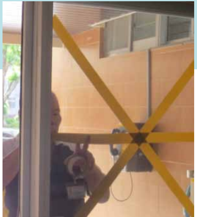
▲ 照服員以膠帶強化落地窗防止玻璃震破割傷
