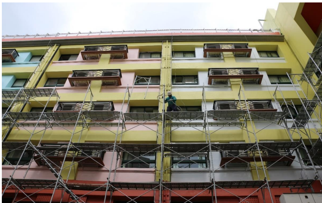
致和樓－進行防漏施工及牆面整體拉皮整修工程
