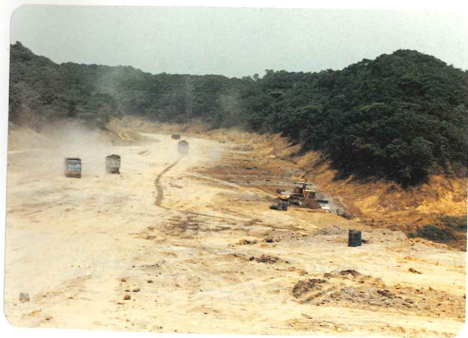
重劃工程施工情形
