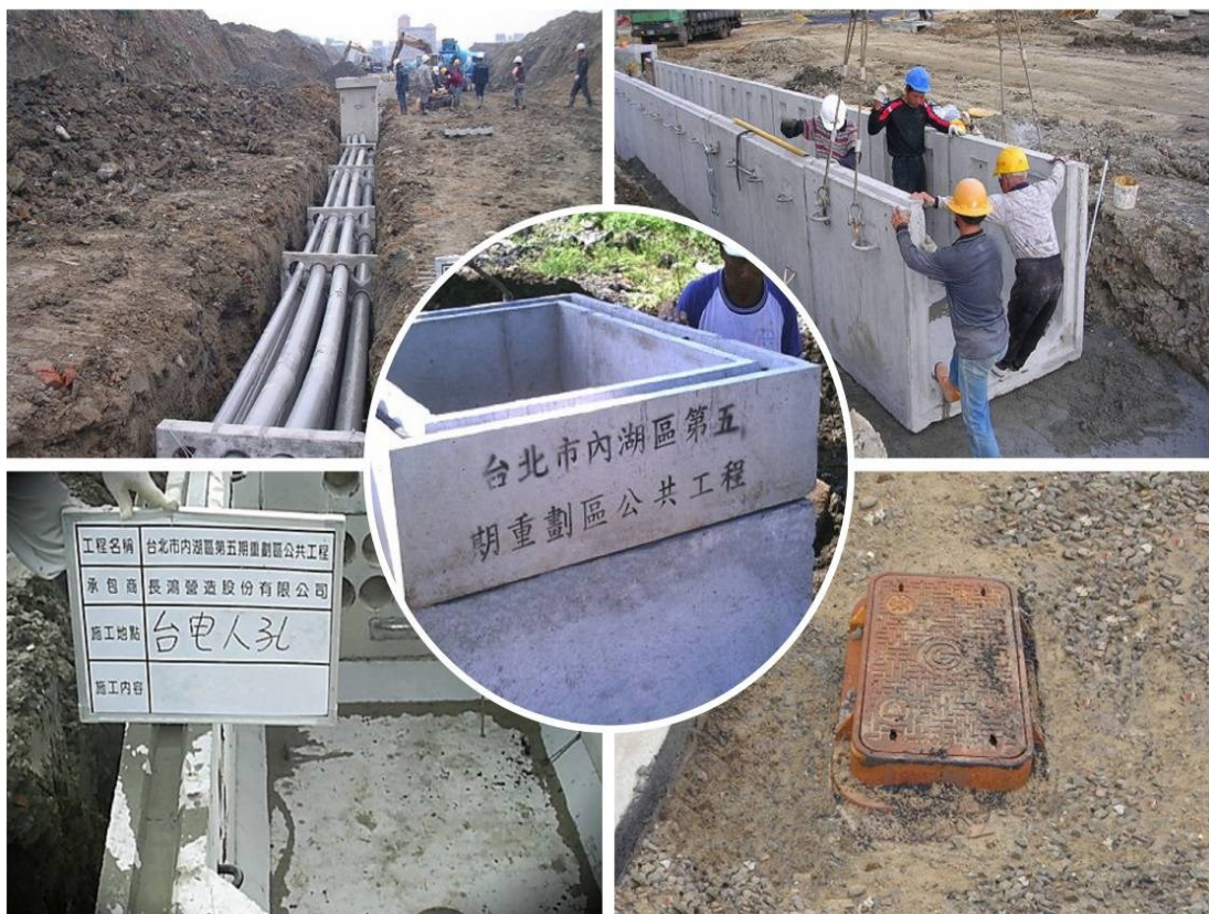
圖 14 區內公共工程施作
