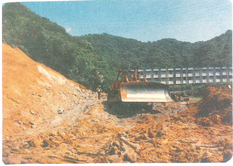
重劃工程施工情形
