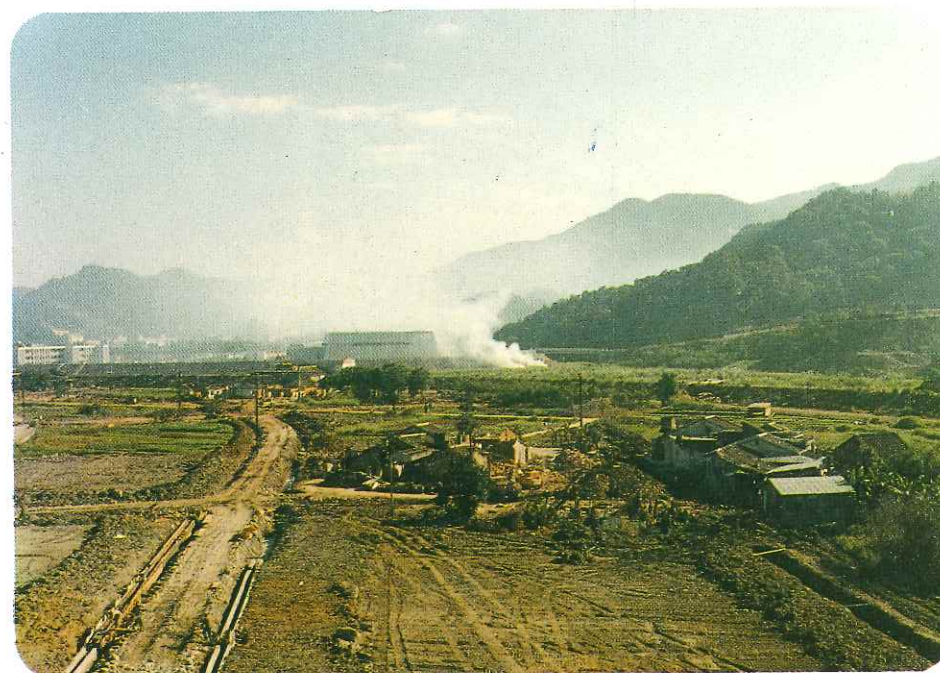
重劃施工中情形
