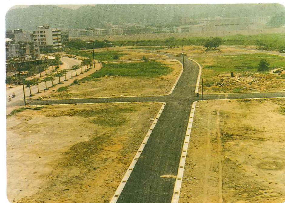
重劃施工後地貌
