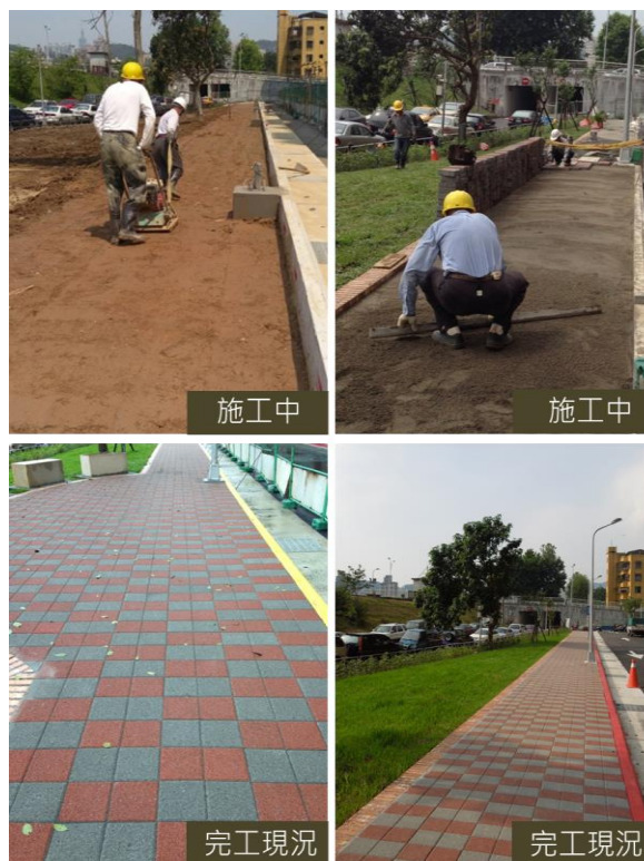
圖14 透水地磚施作過程
