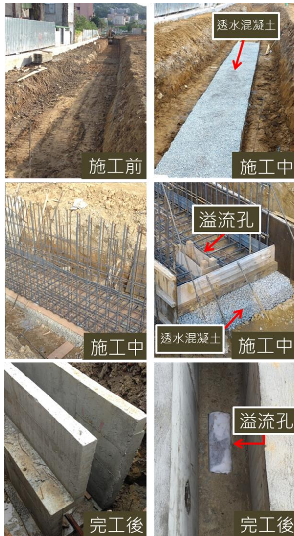
圖15 箱涵式側溝施作過程
