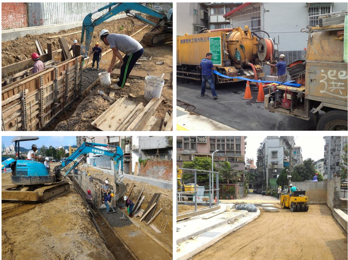
圖9 重劃區施工過程
