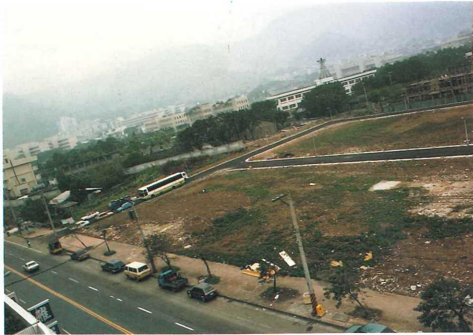
重劃工程施工
