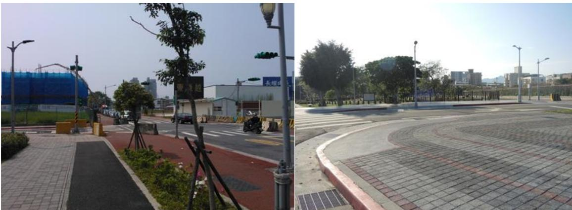
圖 11 透水瀝青混凝土及高壓透水磚照片
