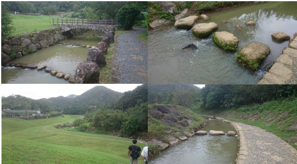
圖 30 臺北市內湖區大溝溪整治工程
