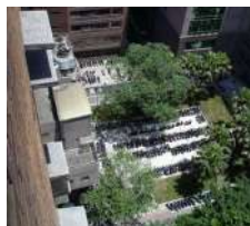
9.中正一等有房屋拆除工程
