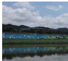
1.臺北市大直橋西側之右岸堤壁
