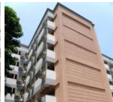
2.新生老人住宅舊翻新工程
