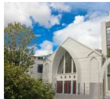
1.廈門街浸信會舊翻新工程
