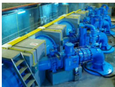
抽水機設備工程
