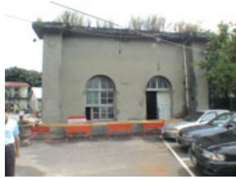
量水室修復前
