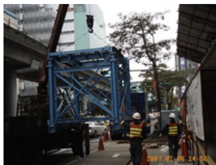
基座及反轉塔架設
