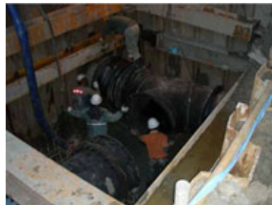
窰井架設橫支撐
