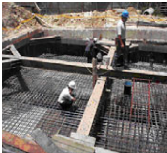
水池 RC 結構施工
