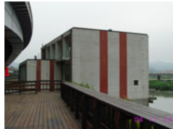
渾水抽水站修復後
