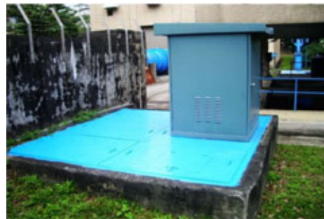
繞流閥窰井蓋版安裝
