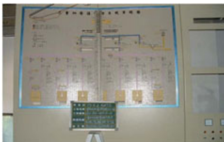
管線及電力系統流程板安裝
