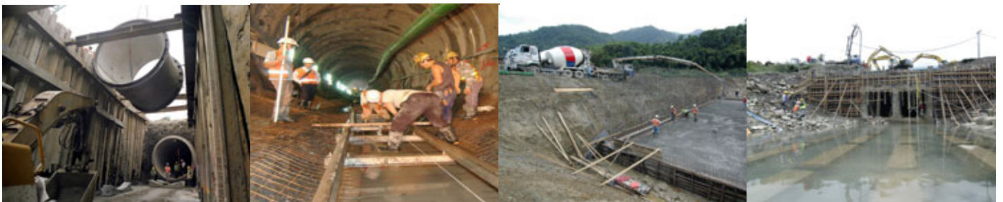
下水涵渠 \phi 4M-PCCP 施工
