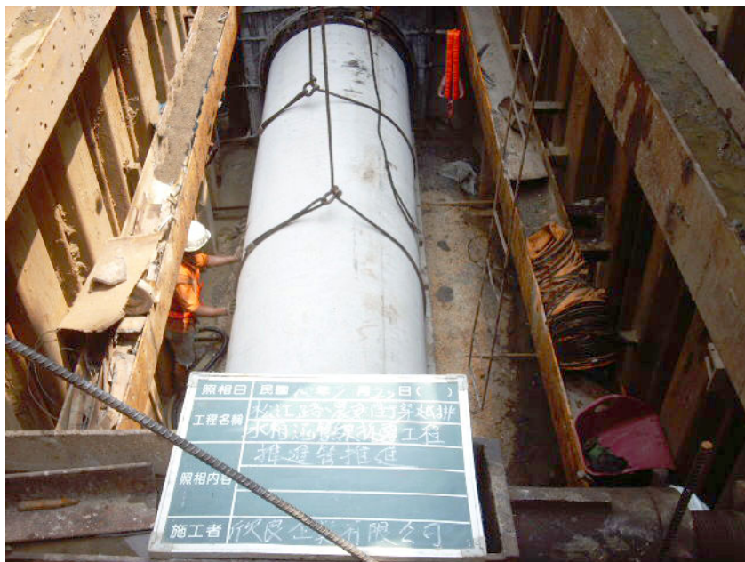
松江路、農安街口穿越排水箱涵管線推進段施工情形
