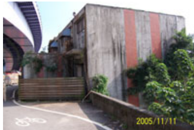
渾水抽水站修復前
