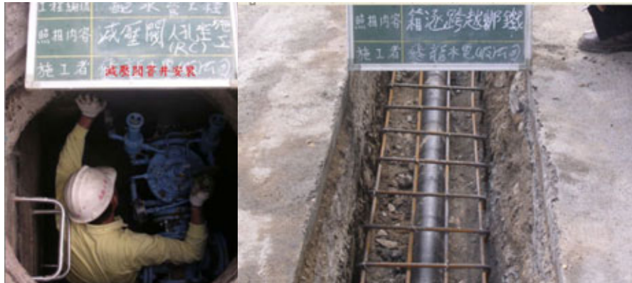
減壓閥窰井安裝
