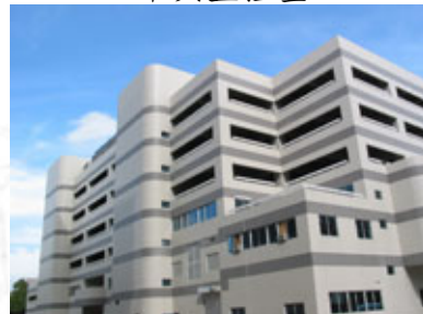
民生加壓站全貌
