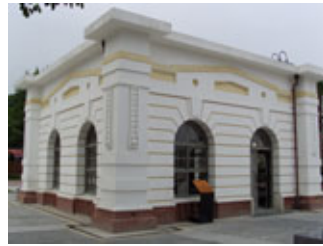
量水室修復後
