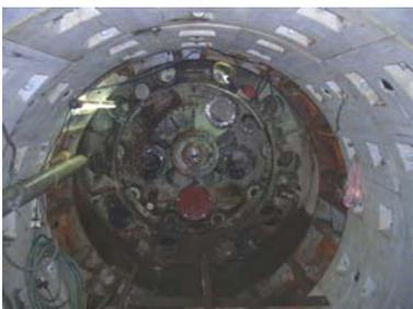
A2→A1 段潛盾隧道到達A1 工作井預定位置後潛盾機組棄殼拆除作業
