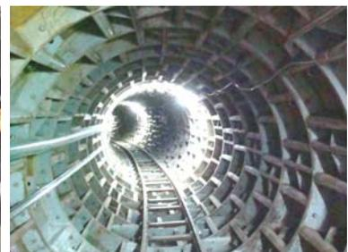
A2→A1 段隧道貫通後急彎段穿管用軌道鋪設情形
