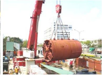
A2→A1 段潛盾機設備吊運入工作井作業
