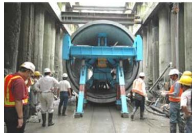
鋼襯預力混凝土管穿管施工
