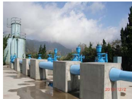
鹿三加清水池施工
