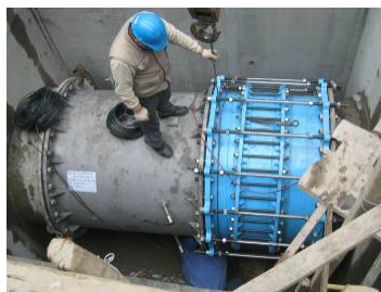
伸縮拉桿安裝
