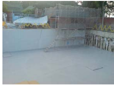
頂版防水層施工
