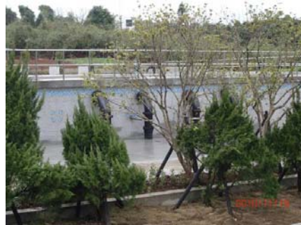
永嶺配水池加壓站水池
