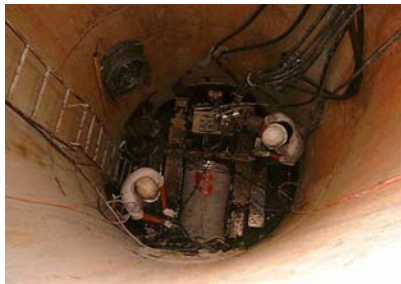
工作井內推進施工
