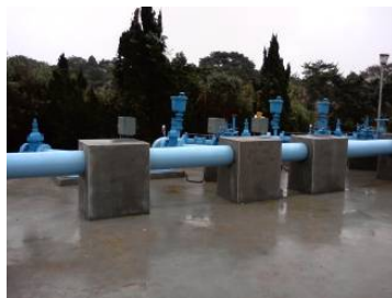
新設加壓站出水幹管
