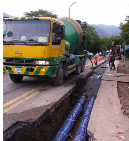
管線施工回填 CLSM
