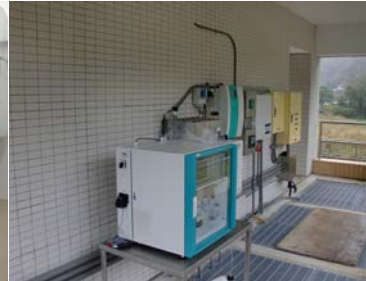
二原水質監測設備
