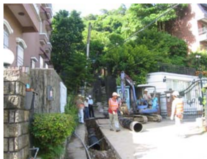
\phi 400\text{mm} 鋼管安放施工中
