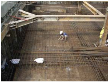
頂版鋼筋及模版施工
