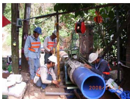
HDPE 熔接及穿管
