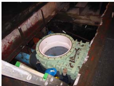
鋼製鞍帶丁字管本體安裝
