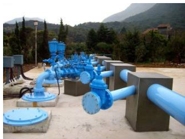
新設加壓站全景
