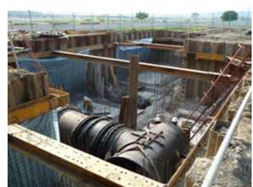
管線連通作業
