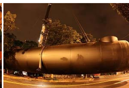
維生槽以吊車吊掛中
