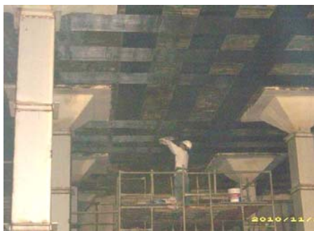
新民加壓站配水池整修
