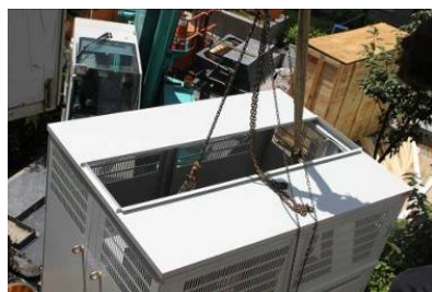
變頻器進場吊運
