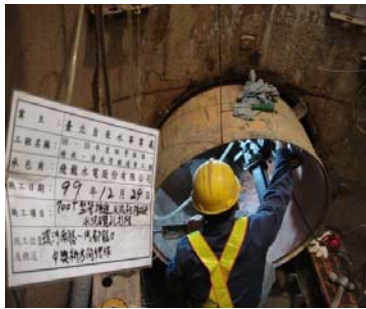
推進井內鋼套環推進施工
