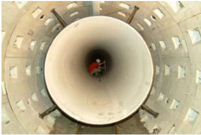
\phi 1500\text{mm} 穿管作業
