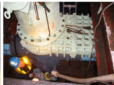
穿孔機鑽孔操作
