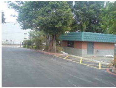
蓄水池及停車場復舊
