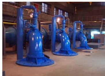
抽水機安裝完成
