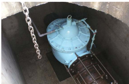
陽明山第 2 停車場配水池工程
