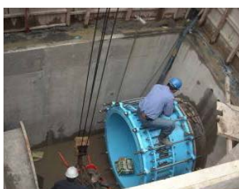
超音波流量計安裝
