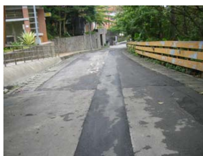
\phi 400\text{mm} 埋設該段 AC 路面完成
