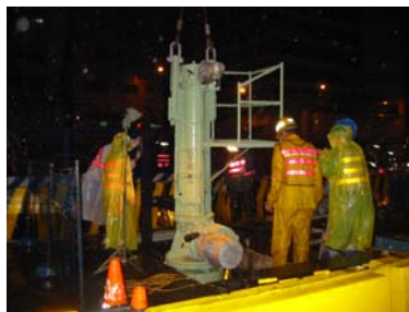
穿孔機吊掛安裝
