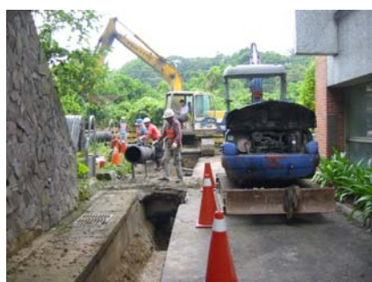
\phi 400\text{mm} 鋼管安放施工中
