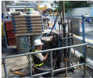
推進井地盤改良施作
