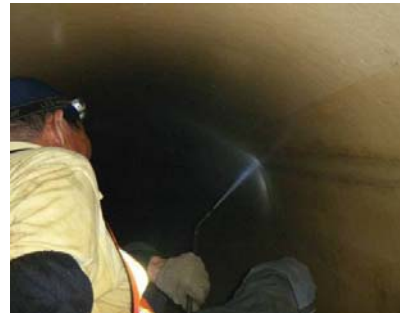
管內清洗作業
