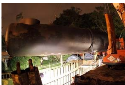
維生槽吊至定位中
