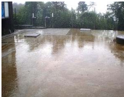
鹿角坑加壓站新設原水池
