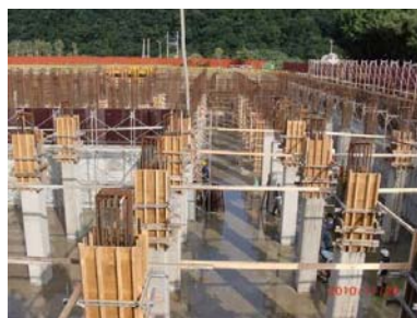
清水池工區池柱昇層施工
