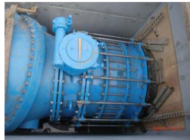
\phi 1350\text{mm} 斜盤式逆止閥、蝶閥及伸縮接頭
