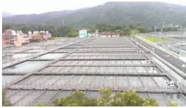
濾前處理設備
