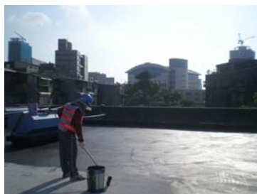
三重加壓站屋頂防水施作
