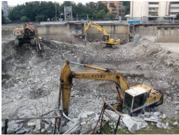
水平舊快濾池拆除
