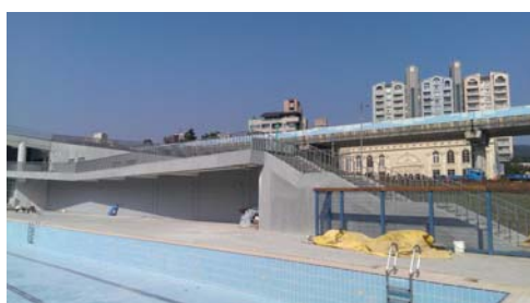
大湖公園維生水池完成照片
