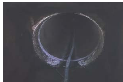
\phi 1200\text{mm} 管內清洗後
