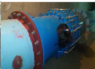
管道內 \phi 1000\text{mm} 超音波流量
