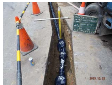
管線安裝埋設
