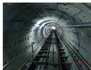
關渡線潛盾隧道
