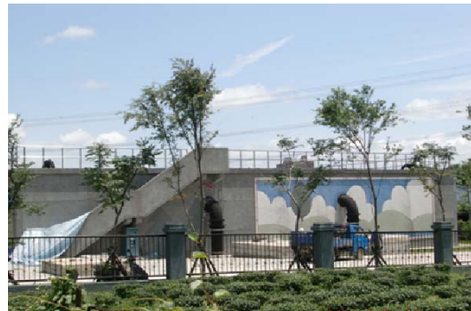
安坑配水池外觀
