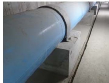
共同管道內鋼管接管及墩座
