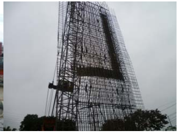
南港加壓站暨配水池工程平面配置圖 南港加壓站連續壁施作 南港加壓站連續壁施作
