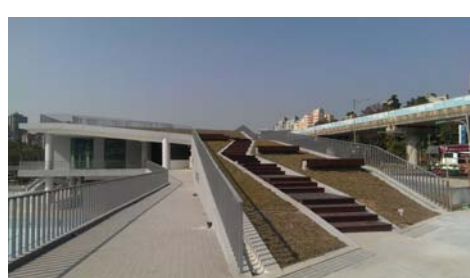
大湖公園維生水池完成照片
