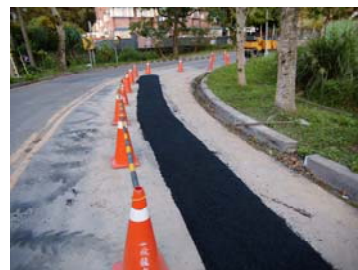
花園新城管線施工
