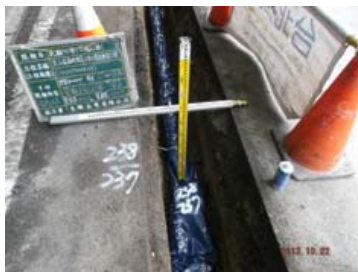
管線安裝埋設
