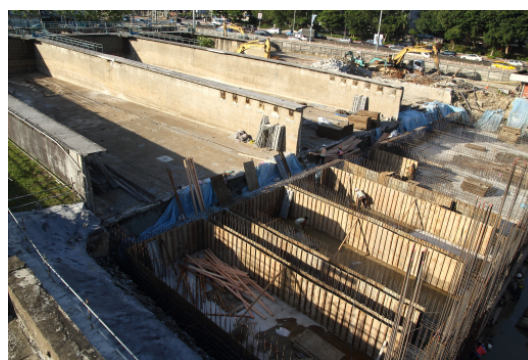
長興淨水場施工情況
