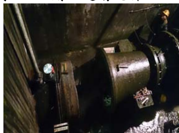
\phi 1200\text{mm} 原水管斷管
