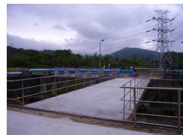
加壓站進出鋼構平台
