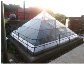
觀音山配水池外觀
