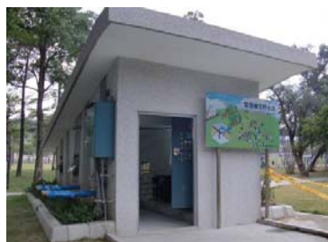
玉泉緊急維生配水池
