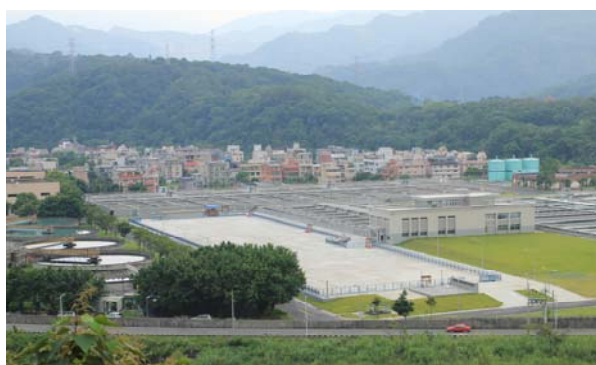
直潭六座工區全景
