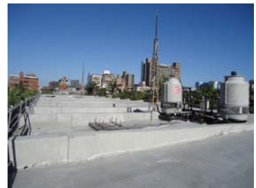
公館加壓站屋頂防水施作
