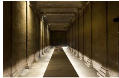
觀音山配水池內部
