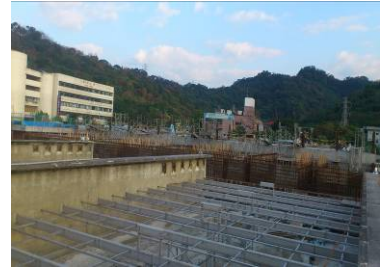
傾斜管支撐架
