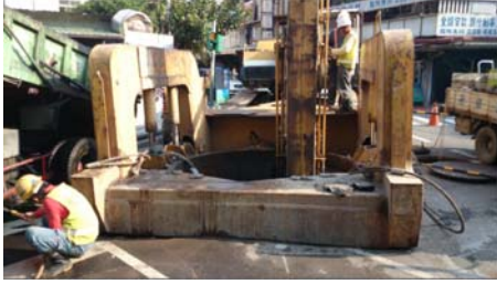
搖管機下鋼套環立坑
