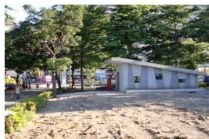
玉泉公園維生配水池出入口
