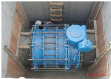
\phi 1000\text{mm} 蝶閥及伸縮接頭
