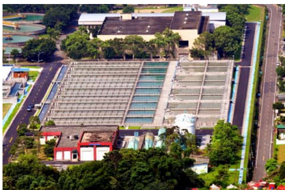
直潭六座濾前處理
