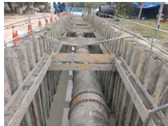
\phi 2000\text{mm} 管線埋設
