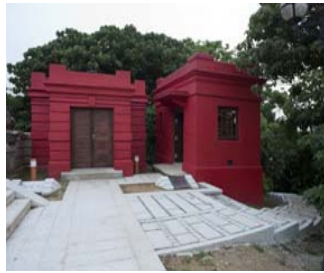
觀音山配水池外觀
