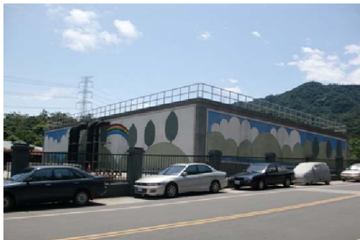
安坑配水池外觀
