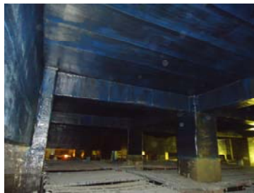
松山配水池鋪貼結構補強碳纖維
