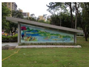
青年公園維生配水池出入口
