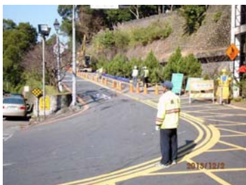
花園新城管線施工
