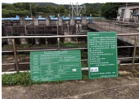
施工告示牌及柔性告示牌
