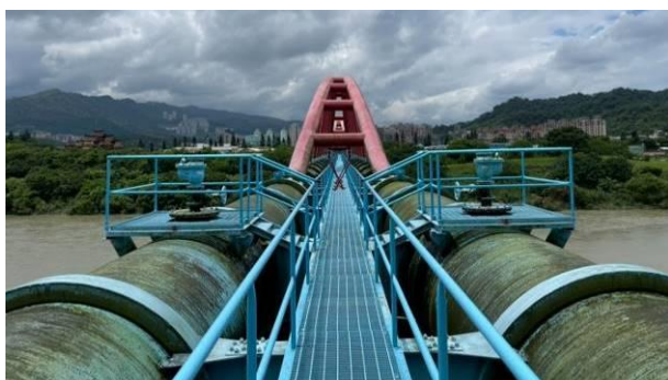
新店溪水管橋完工
