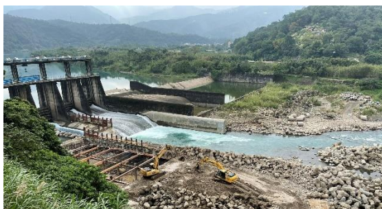
右岸靜水池擋土開挖作業
