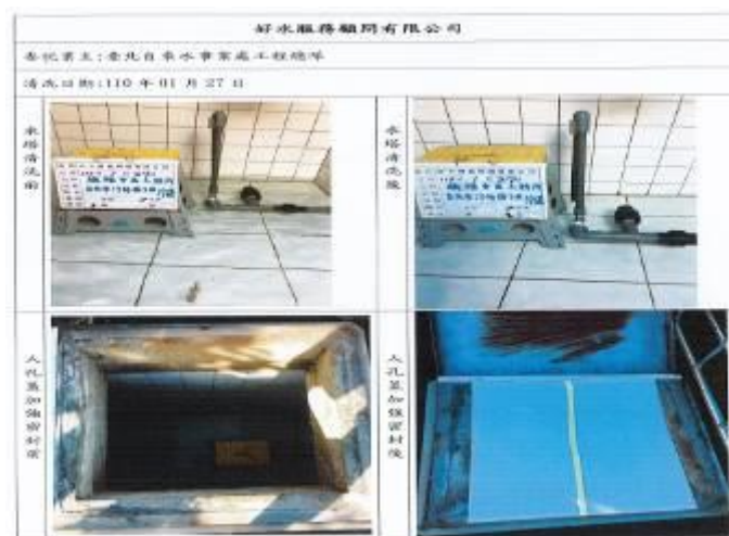
第2辦公室水塔清洗
