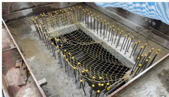
大同一座新設窰井切割完成
