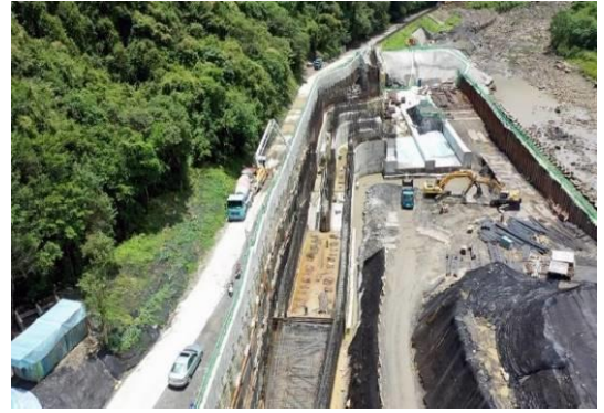
取水口排砂道施工
