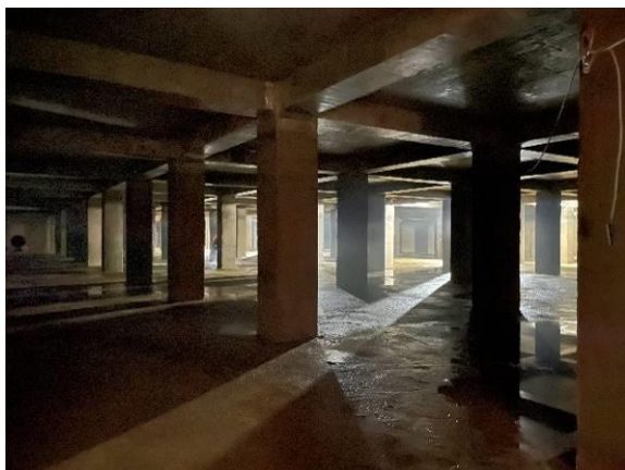
大同二座配水池檢視清洗完成
