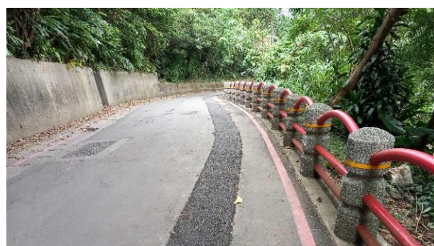
完成管線埋設
