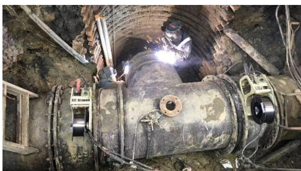
新舊管線連絡施工
