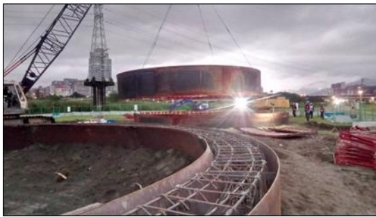
壓入式沉箱內模組立
