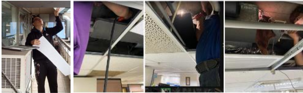
更換全熱交換器濾網，檢視中央空調接水盤及排水管
