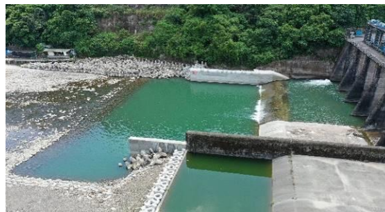
青潭堰靜水池及下游保護工完工全景
