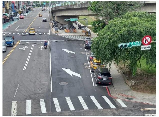
新北端復舊完成
