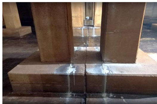
大同一座配水池柱底墩座切割
