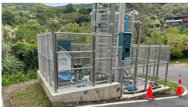
完成第 2 座配水池加壓站
