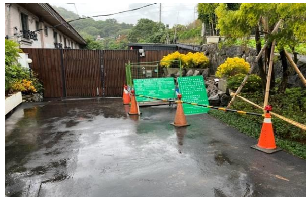
到達井開挖作業
