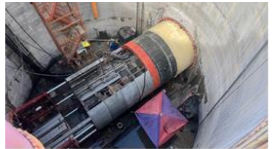
消壓塔端破鏡
