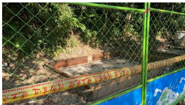
完成基礎整地作業
