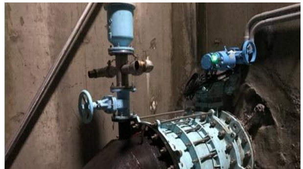
完成增設電動操作機
