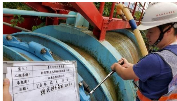
監造螺栓扭力量測
