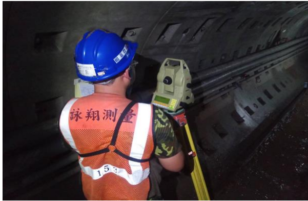
複測作業施作
