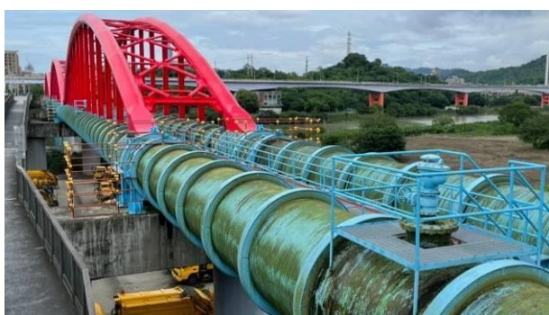
永福水管橋完工
