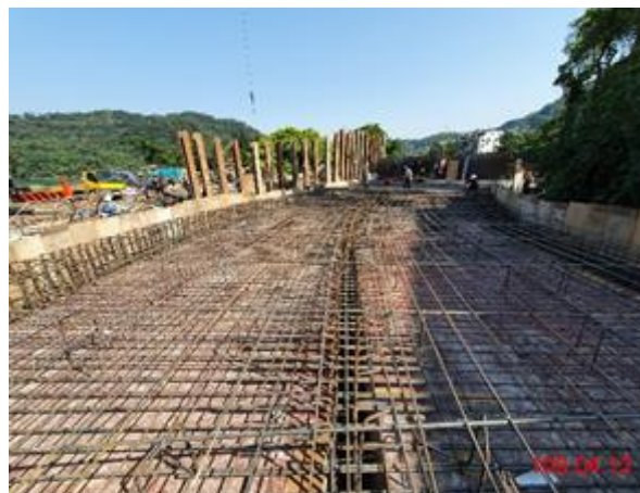
涵渠頂板鋼筋綁紮
