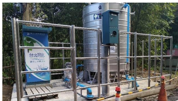
完成機電設置
