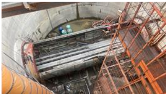
消壓塔端破鏡完成
