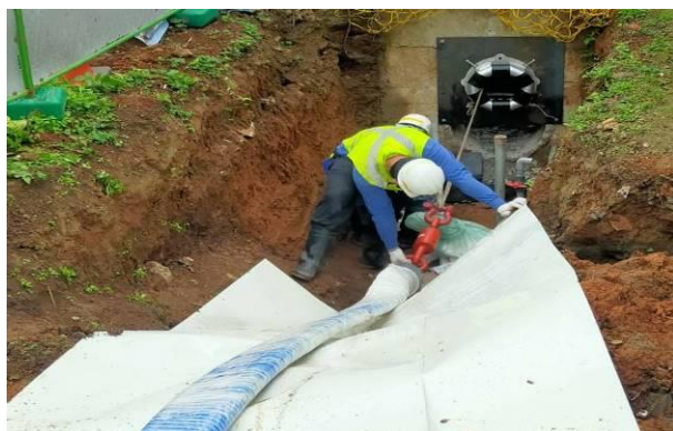
穿管作業前設施整備
