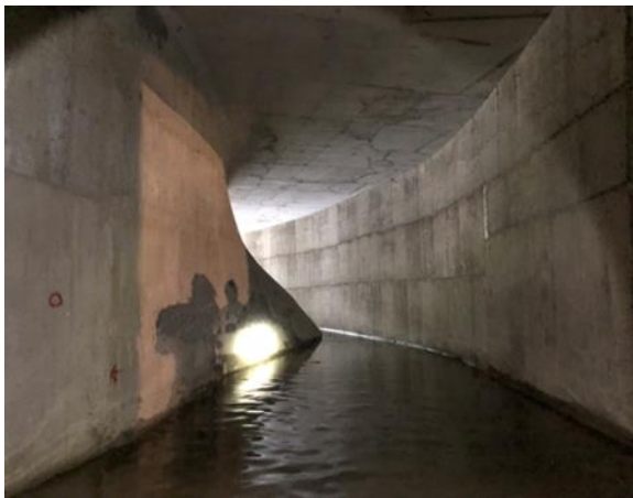
涵渠出水口匯流段
