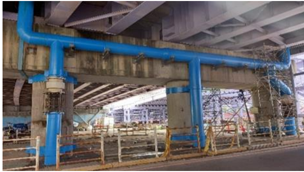
配合新工處中正橋拆除工程(新北端) \phi 600mm 及 \phi 500mm 等管線臨遷分案工程
