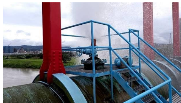
永福水管橋南側管線止水測試
