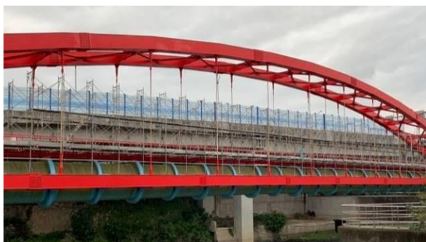
圓山 A 橋施工
