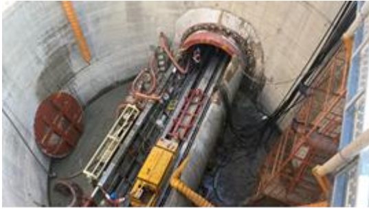
後指部端破鏡完成
