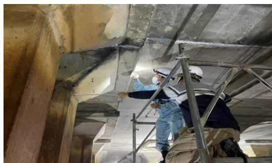
大同一座配水池伸縮縫丈量
