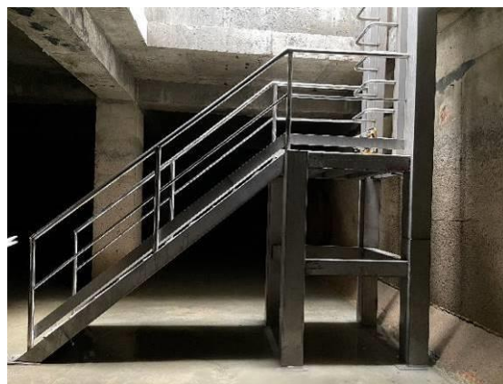
大同二座配水池新增上下爬梯
