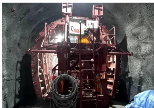
主隧道襯砌鋼模
