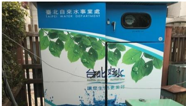
完成配電盤汰換
