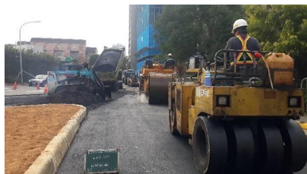
路面復舊施工
