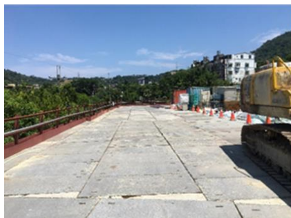
鋼構橋便橋及構台
