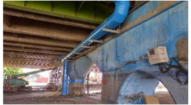
配合新工處中正橋拆除工程(新北端) \phi 600mm 及 \phi 500mm 等管線臨遷分案工程
