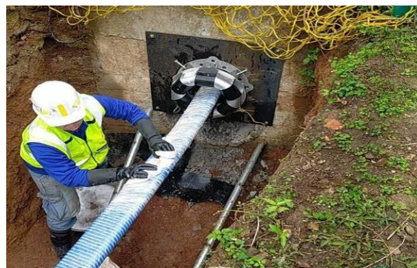
49 號窰井穿管作業
