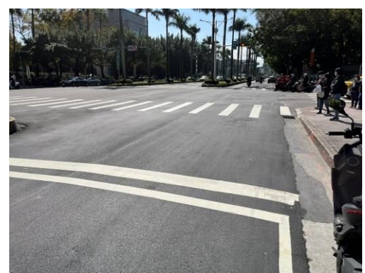
配合新工處常德街人行地下道 \phi 300mm 自來水管線臨遷分案工程
