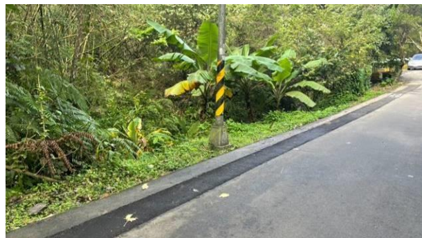
完成主要道路管線埋設
