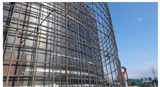
沉箱壁體鋼筋
