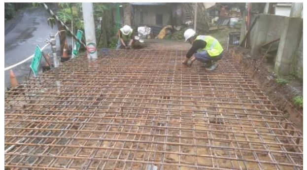
施作鋼筋綁紮
