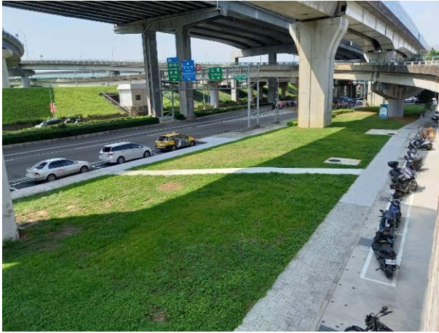
新北端復舊完成
