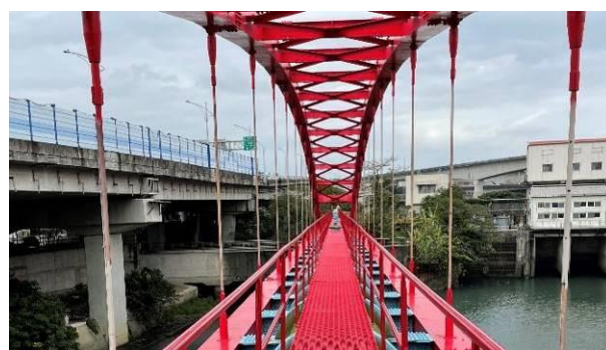
圓山水管橋完工
