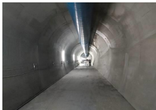
主隧道混凝土襯砌
