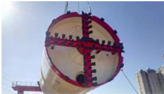
潛盾機吊放(消壓塔端)
