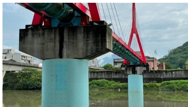
劍潭水管橋完工
