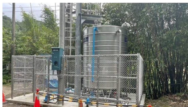
完成第 1 座配水池加壓站
