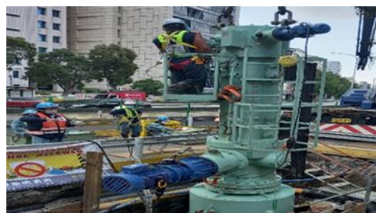
大安區新生南路 \phi 800\text{mm} 增設
