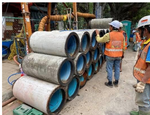
穿管前 T 型短管清潔作業
