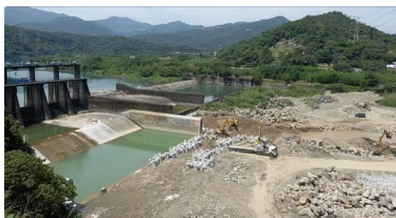
靜水池下游鼎塊吊放
