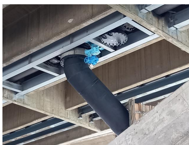
臺北端連絡完成
