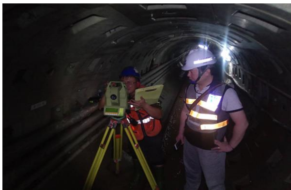
複測作業施作
