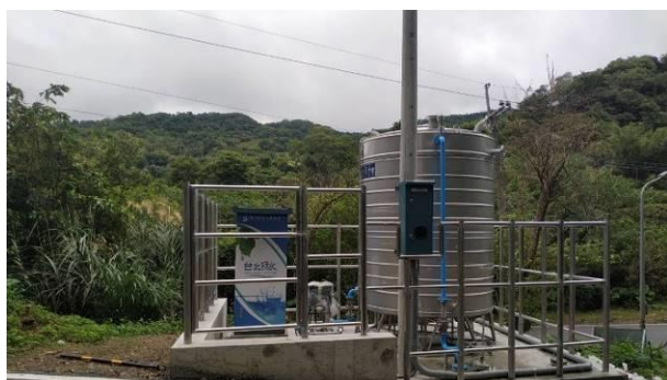
完成機電設置
