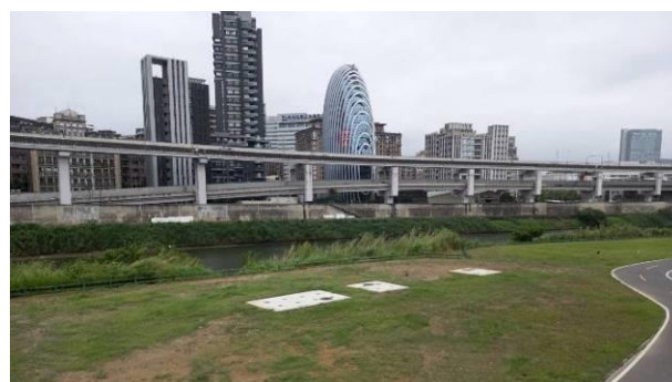
發進井完成復舊
