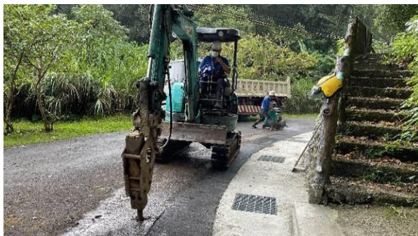
管線埋設施工
