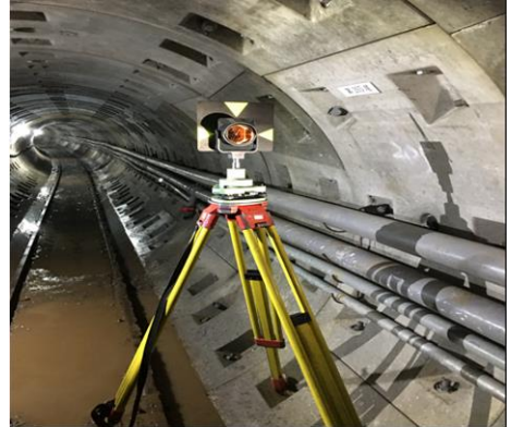
複測作業施作
