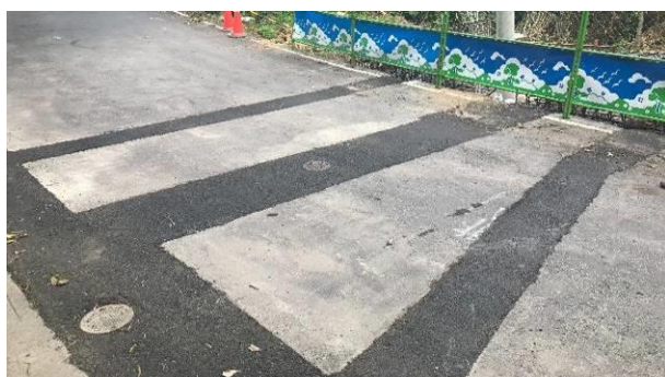
完成進出配水池管線預留
