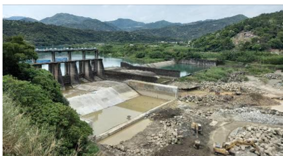
靜水池結構體完成
