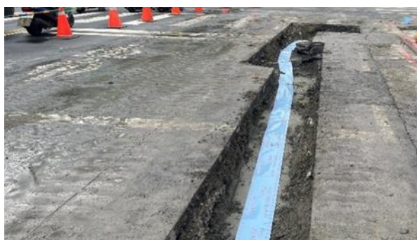
建國北路二段(長春路口) \phi 200mm 等管線遷移分案工程
