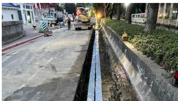
信義路一段(中正紀念堂側) \phi 500mm 管線汰換分案工程
