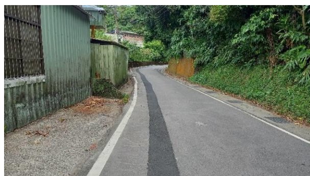
完成管線埋設
