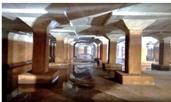
大同一座配水池停水完成
