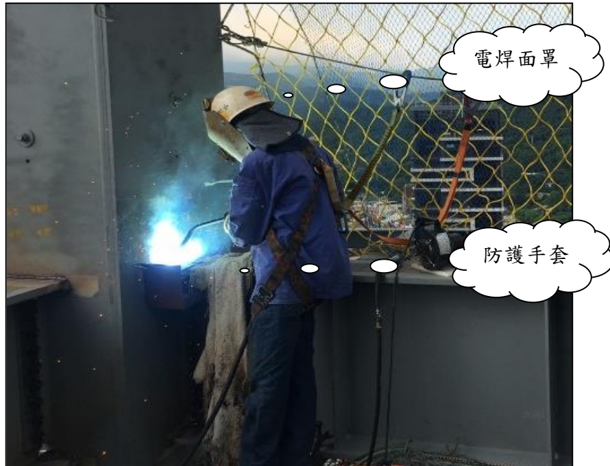
圖十四、 施工架或鋼架上從事電焊作業,電焊機除具自動電擊防止裝置,人員應戴電焊用防護面具及皮手套以防火花濺傷
