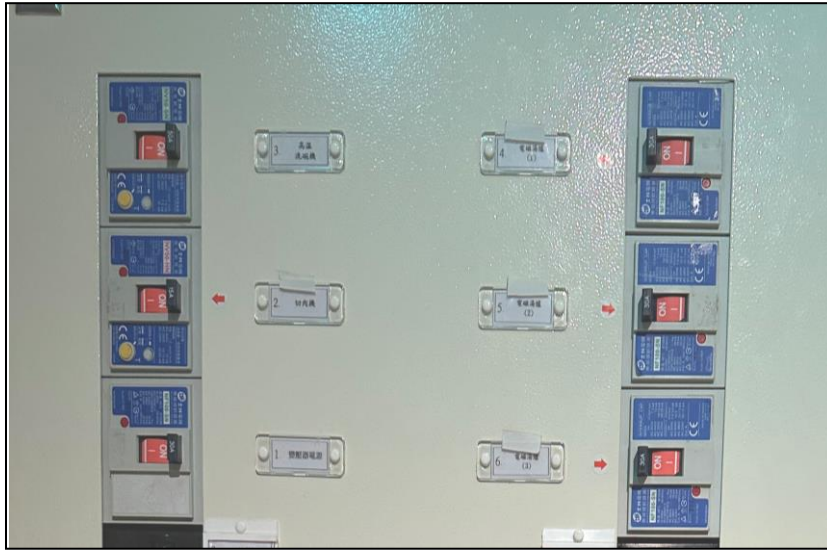
圖二十、開關應明顯標示其啟斷操作及用途 法令依據：職業安全衛生設施規則第 248 條
