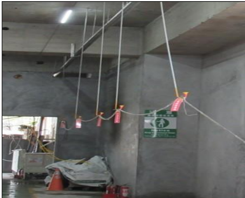
圖十七、電線架高避免置於潮濕地面
