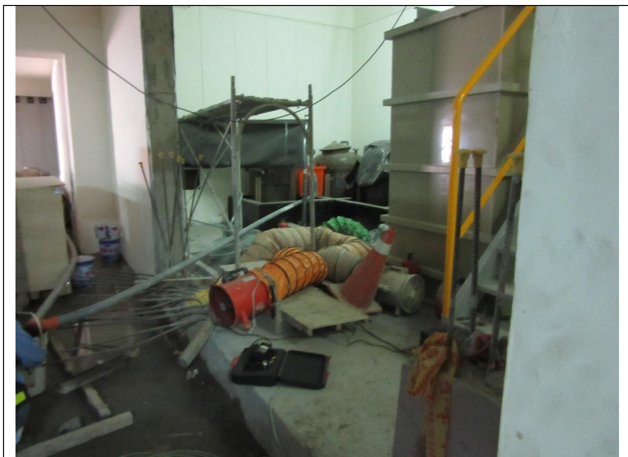
說明一 汙廢水池防蝕工程現場作業情形。
