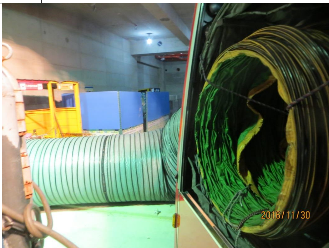
說明二 救災現場，消防局通風排氣情形。
