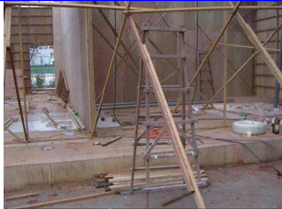
說明：現場使用木合梯無堅固之構造、兩梯腳間無繫材扣牢、無安全之梯面。
