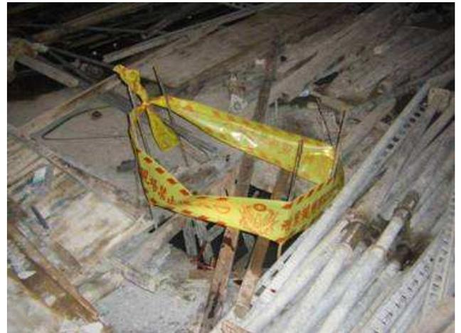
說明：地下二樓中間樁開口暴露鋼筋未採防護設施
