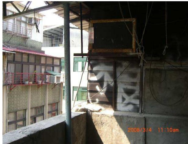
說明：勞工從事外牆冷氣拆除作業，應先量測外牆寬度是否能提供足夠之踏面寬度，並評估現場環境是否適合以攀爬方式，沿外牆行走。宜使用高空工作車或使用安全帽及安全帶等防護具後進行作業。
