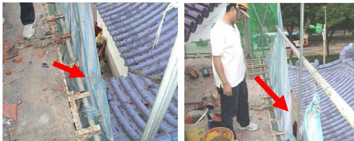
中正紀念堂○○門頂層施工架護欄未設置中欄杆，導致罹災勞工向後踩空自上欄杆與水平踏板間開口墜落至下方圍牆屋簷，再翻落至地面。
