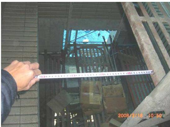
說明：施工架與結構體間距離約40公分無任何防墜設施。
