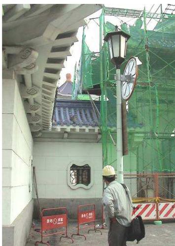
罹災勞工自施工架墜落至圍牆屋簷，再翻落至地面（總垂直落距6.8公尺）。
