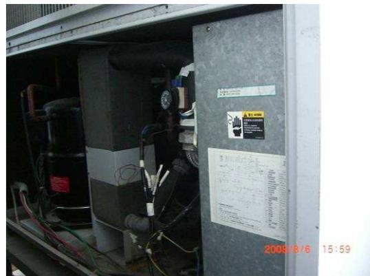
說明：作業現場空間狹窄。對於從事接近電路之勞工，未使其「斷電」、「檢電」、「隔離」、「穿戴防護具」等再行作業。
