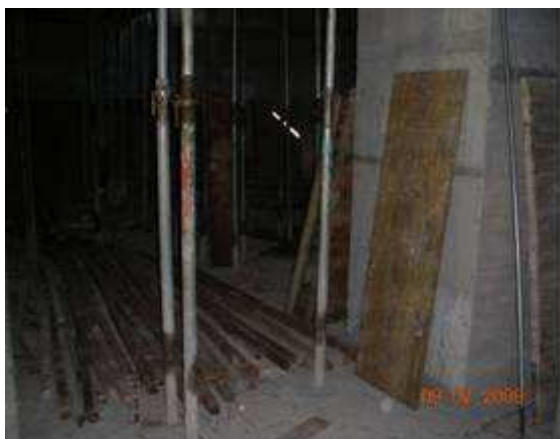
說明：勞工拆模位置。
