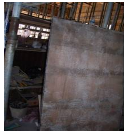
說明：地下 1 樓上方施工平台堆置用來鋪設底板之夾板(共約 100 片，每片長度 183 公分、寬 91 公分、厚 1.3 公分、重約 10 公斤)。
