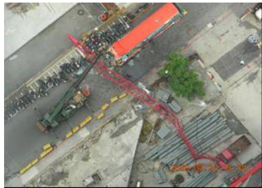
說明：B人字臂起重桿吊桿掉落位置。
