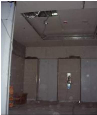
說明：罹災者當日之作業位置。（作業內容為天花板內弱電系統配線作業）
