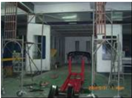
說明：堆高機貨叉未降至地面，移動至斜坡時重心不穩傾倒。
