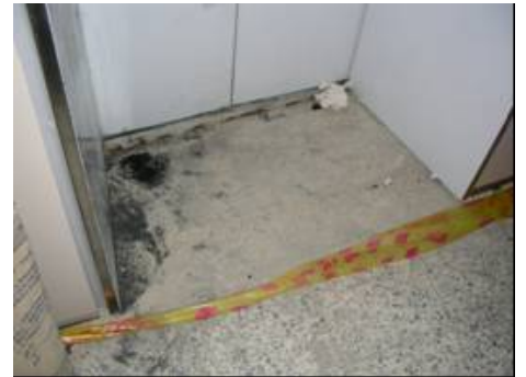
說明：罹災者墜落至地下 1 樓機坑處。
