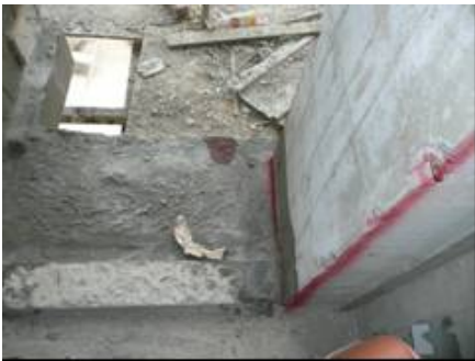
說明：罹災者墜落至 2 樓施工架三角托架上之平台。
