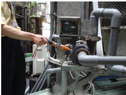
說明：職災現場照片。
