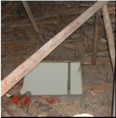
說明：天花板維修孔。
