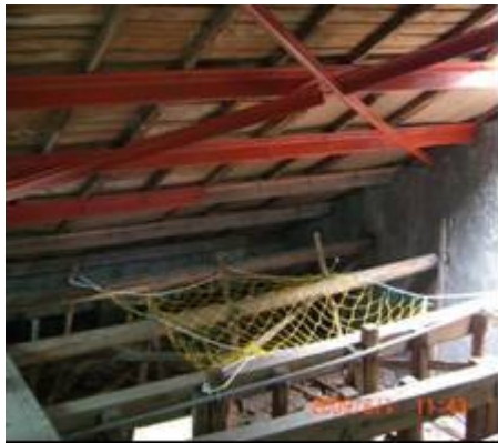
說明：屋架塗紅丹漆防鏽作業。
