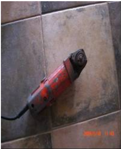
說明：現場切割機無護罩。
