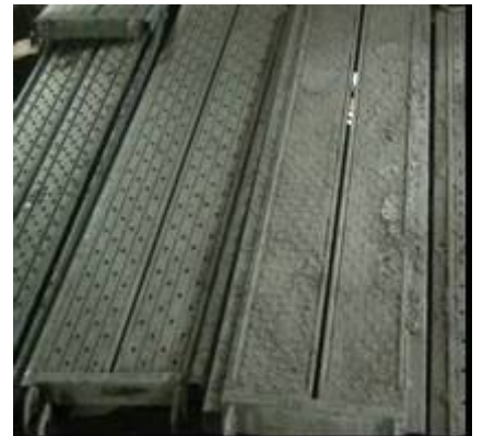
說明：作業區域施工踏板滿鋪。
