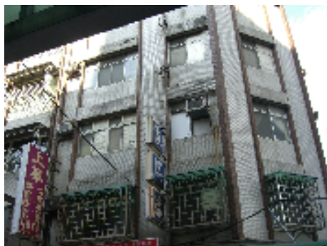
說明：自高度約 3 樓樓地板處墜落。
