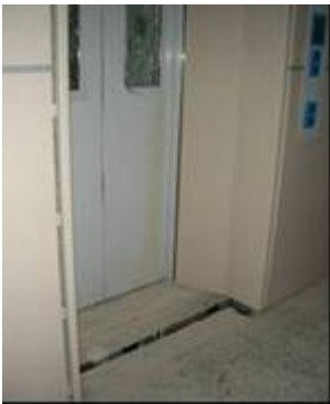
說明：1 樓電梯門關閉情形。
