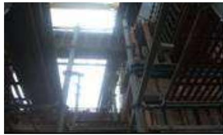
說明：鋼柱與重型支撐架間之開口情形。
