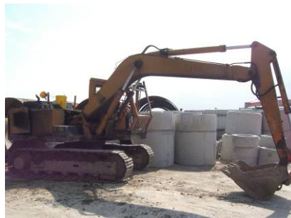
說明：以挖土機進行吊運作業。
