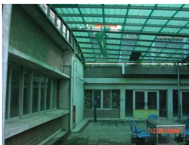
說明：雨棚現場照片。
