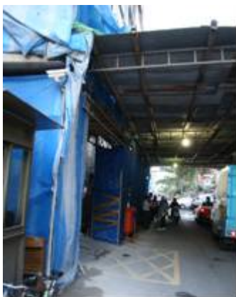
說明：鐵皮棚現場照片。
