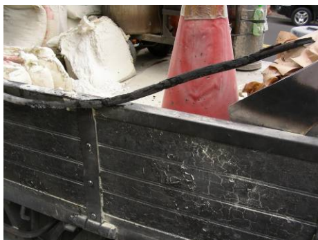
說明：瓦斯管線破裂情形。
