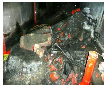
說明：現場鄰牆之倒塌 情形。
