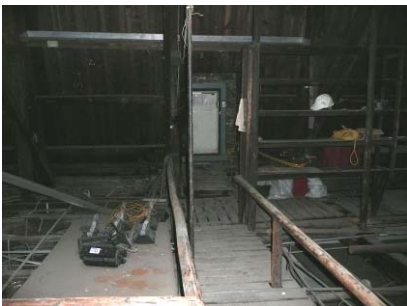
說明：3 樓閣樓貓道。
