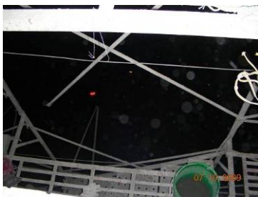
說明：施工架開口未設防護設置。
