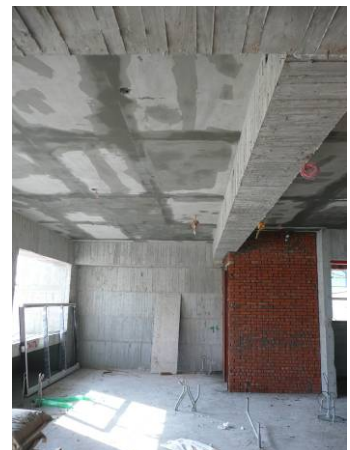
說明：現場頂板批土作業。
