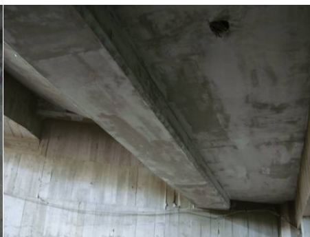
說明：現場進行平頂批土作業。
