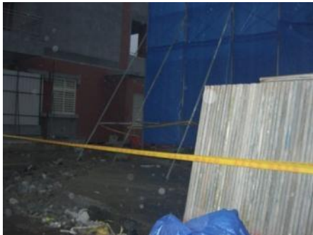
說明：傷者許○○從事施工架搬運作業。
