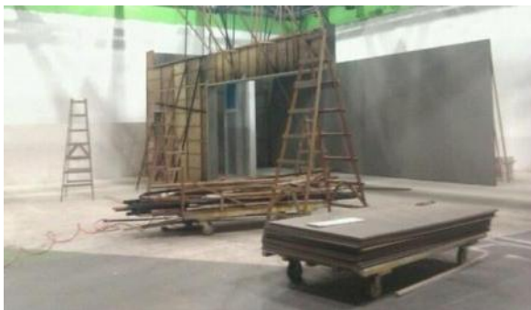
說明：搭設景片現場。
