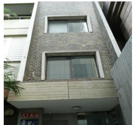
說明：事故現場全照圖
