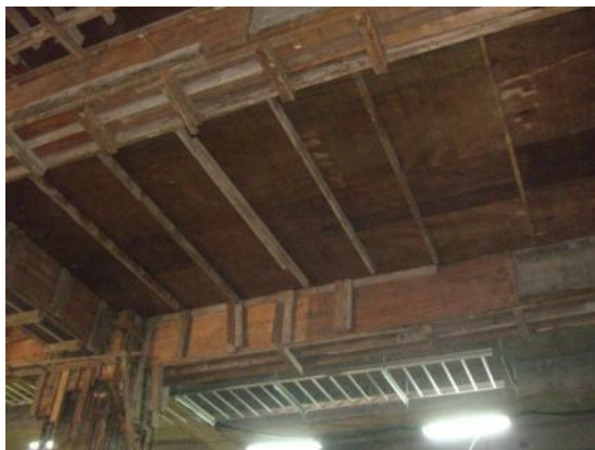
說明：現場模板拆除現況
