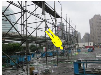
說明：洪員約在第2層位置作業，研判當時洪員未確實鉤掛安全帶，致移動時從架上跌落至地面（落距約為2~3公尺）。
