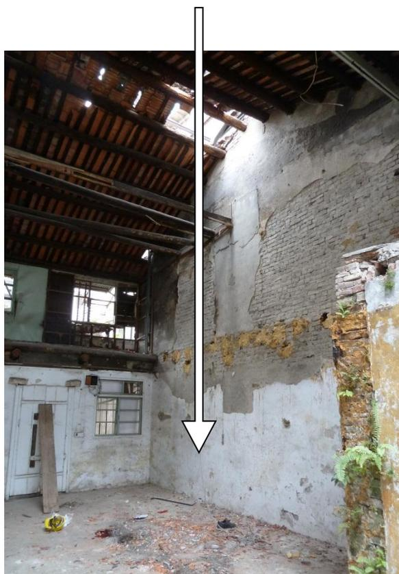
說明：勞工踏穿屋瓦自2樓屋頂墜落至1樓地面（高度約7.2公尺）現場。
