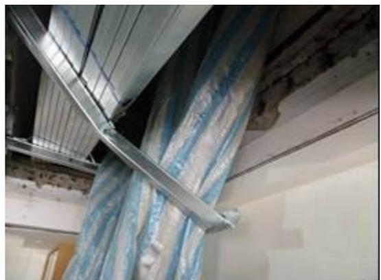
說明：樓板因無法承受罹災者之重量而倒塌，造成罹災者自輕質樓板上墜落地面。
