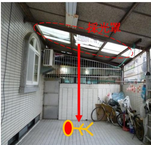
說明：罹災勞工踏穿採光罩後墜落至地面。
