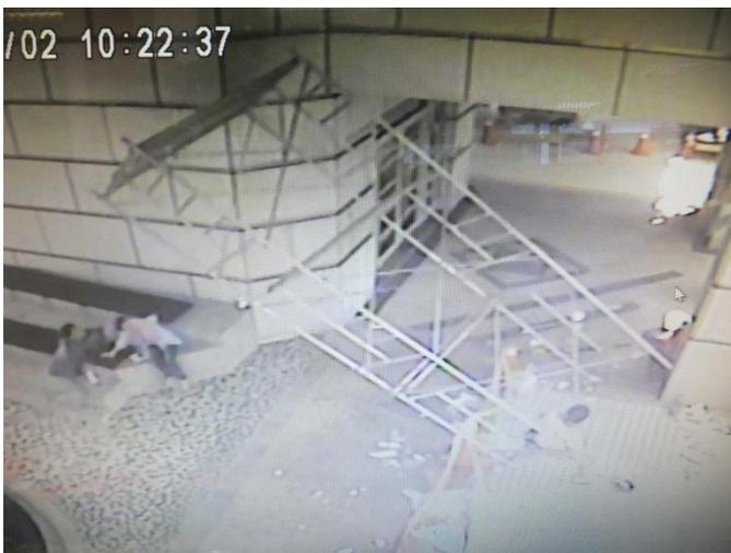
說明：施工架倒塌造成罹災者頭顱受創死亡。
