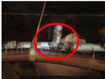
說明：王員當時施作消防管電焊補強之管線。
