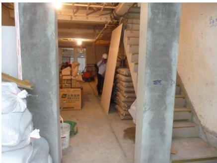
說明：室內裝修之施工現場。
