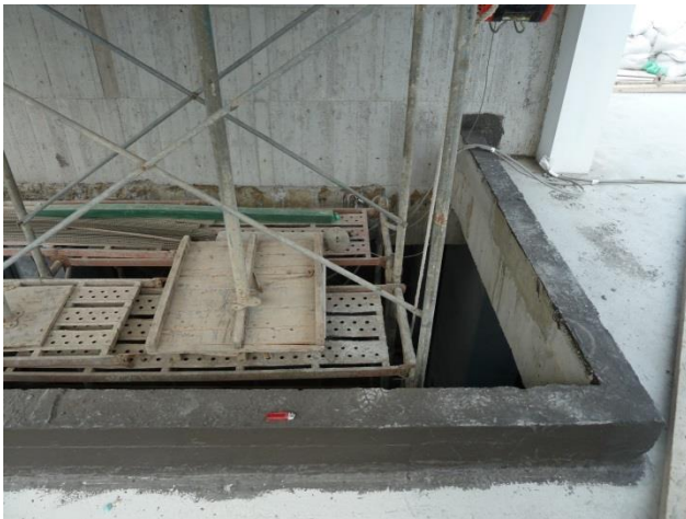
說明：現場施工現況。
