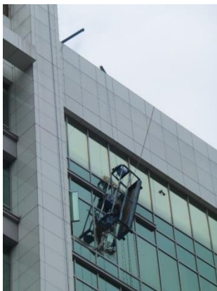
說明：吊籠懸掛在空中之情形。
