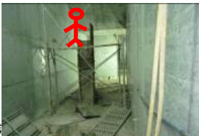
乙炔進行中間柱燒切作業。
