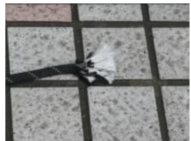
說明：繩索斷裂情形。
