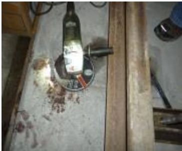
說明：災害作業現場。 說明：災害作業現場。
