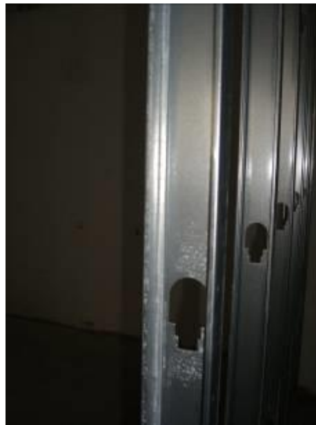
說明:現場組立後的鋼材
