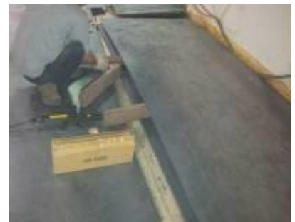
說明：物料之搬運，應利用 千斤頂等機械以替代 人力
