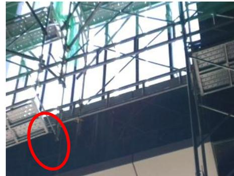
施工架踏板未確實綁結固定。
