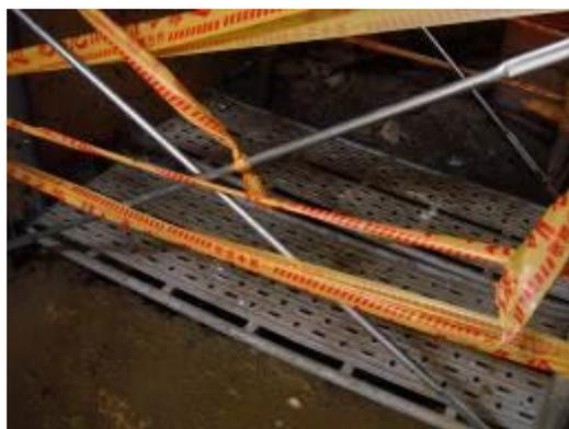
說明：地下1樓板開口現場改善（設置護欄及護蓋等防墜設備）。
