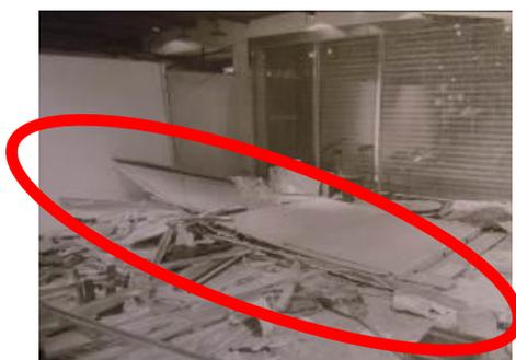
說明：拆除無支撐之牆未以適當支撐避免崩塌(現場照片)。
