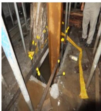
說明：案發時鋼筋保護套已脫落，圖為事後所加裝之護套措施。
