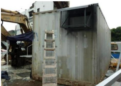
說明：勞工在工地1樓貨櫃屋頂上（高2.6m）進行石塊清理作業，因未設置防墜設備，不慎跌倒摔落至地面上。
