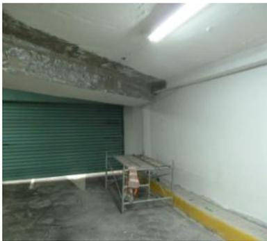
說明：該施工架高度為90公分，暴露鋼管突出處未加裝護套防護。
