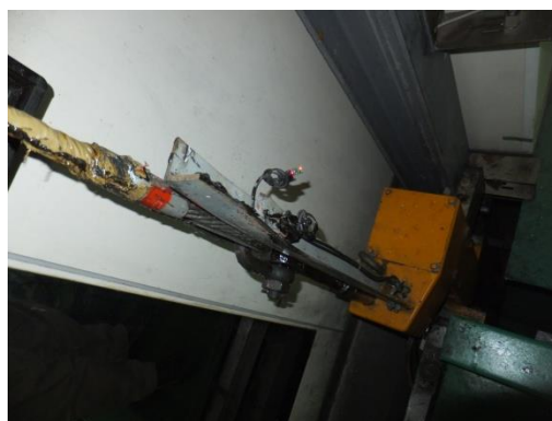
說明：支柱被壓至變形。
