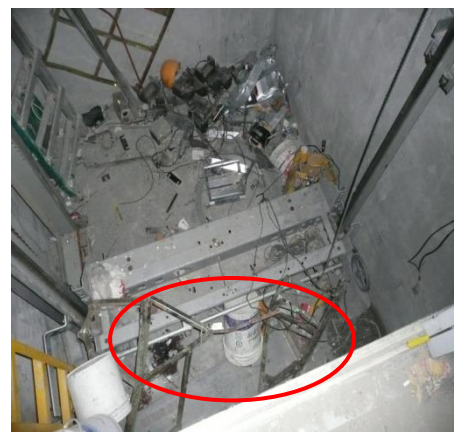
說明：延伸工作臺護欄
