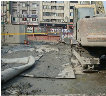
說明：作業時地面泥濘，地面已鋪設鐵板
