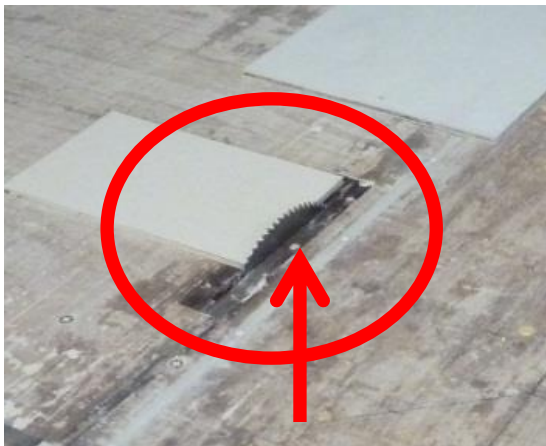
說明：木材加工用圓盤鋸未設置覆蓋。
