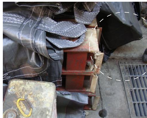
說明：推進作業使用之墊塊。
