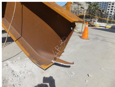
說明：掉落鋼樑嚴重變形。
