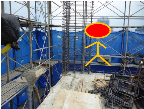
說明：勞工於10樓進行柱筋綁紮作業。
