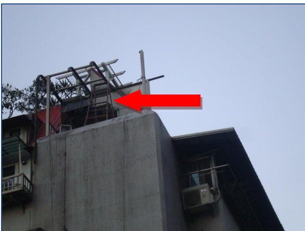
說明：罹災勞工吳○○站於露臺之鐵合梯上進行舊採光罩骨架拆除作業。
