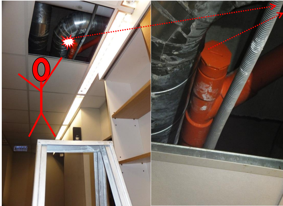
說明：罹災者打開排水管氣孔蓋遭鹼性疏通劑灼傷之模擬照片。
