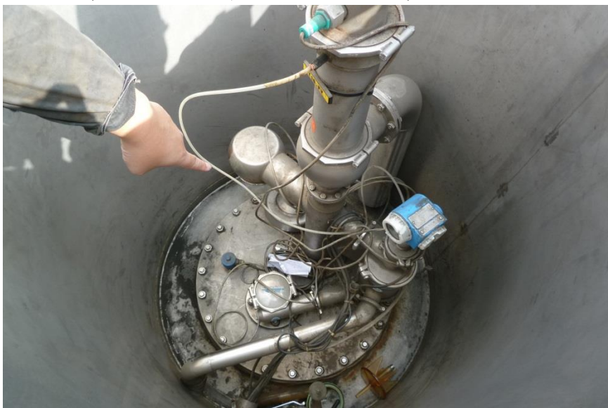
說明：頂部真空閥頂蓋桶內進行維修作業現場(災害發生)
