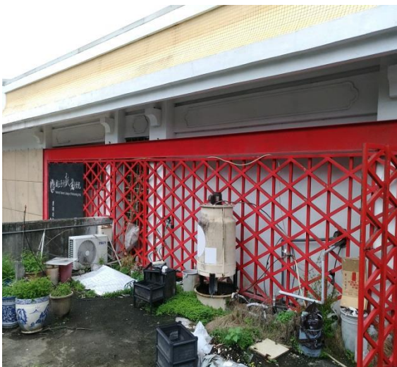
說明：受傷勞工於工地從事油漆粉刷作業。
