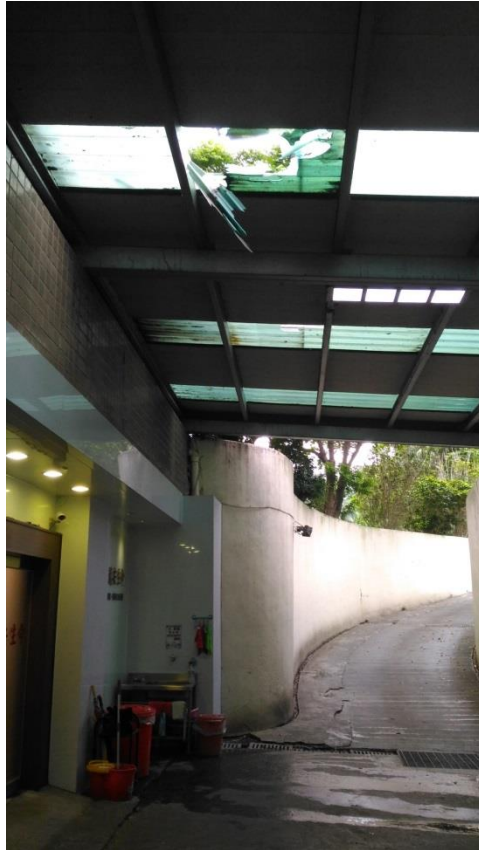
說明：採光罩至地下車道高度為 4.64 公尺。
