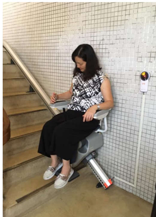
樓梯以樓梯附掛式昇降椅改善
