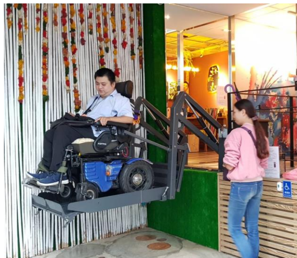
避難層出入口高低差以升降平台改善
