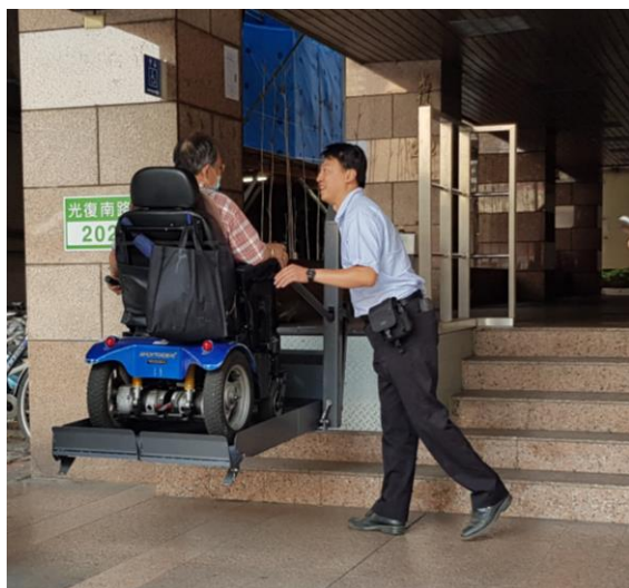
避難層出入口高低差以升降平台改善
