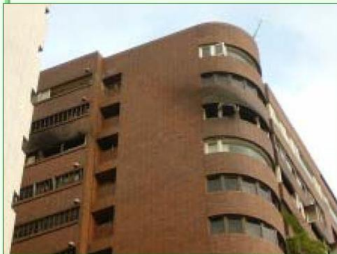
▲室內施工人員在油漆作業中抽煙，不慎釀成大火案例
