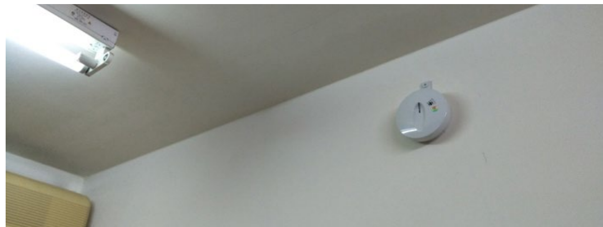
圖 2 裝設住宅用火災警報器
