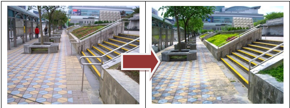
扶手端部處理(改善前)
