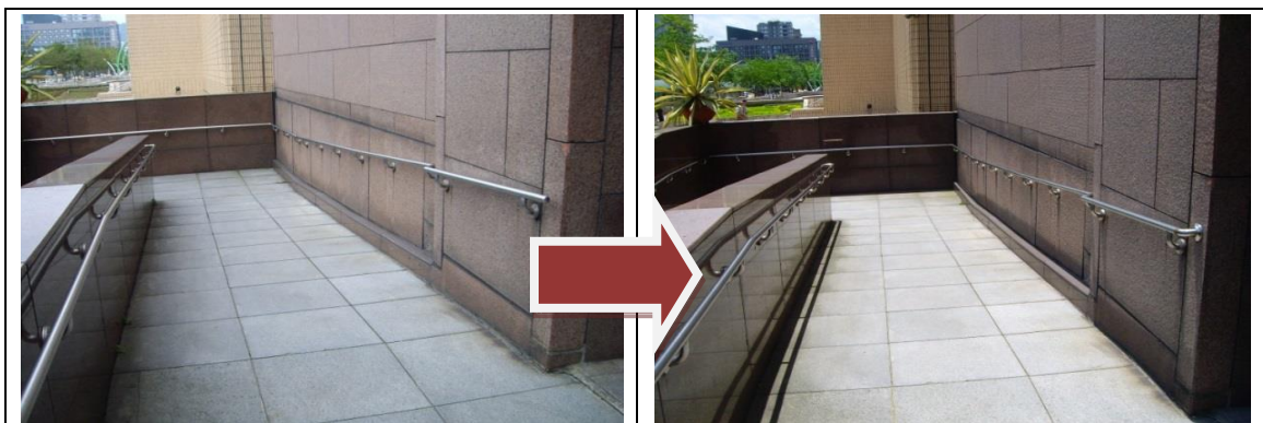
扶手端部處理(改善前)
