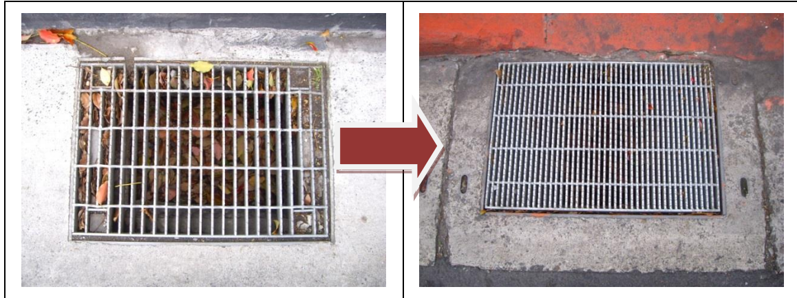
水溝格柵(改善前)
