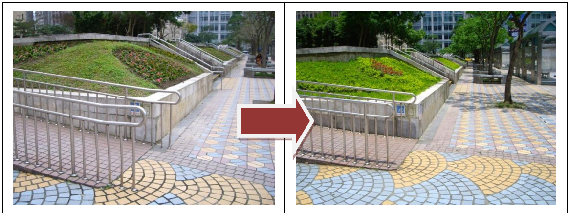
扶手端部處理(改善前)
