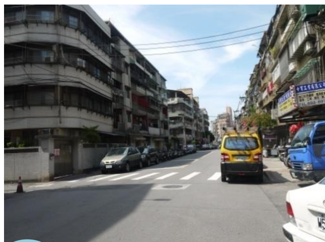
13 基地北側○○街現況
