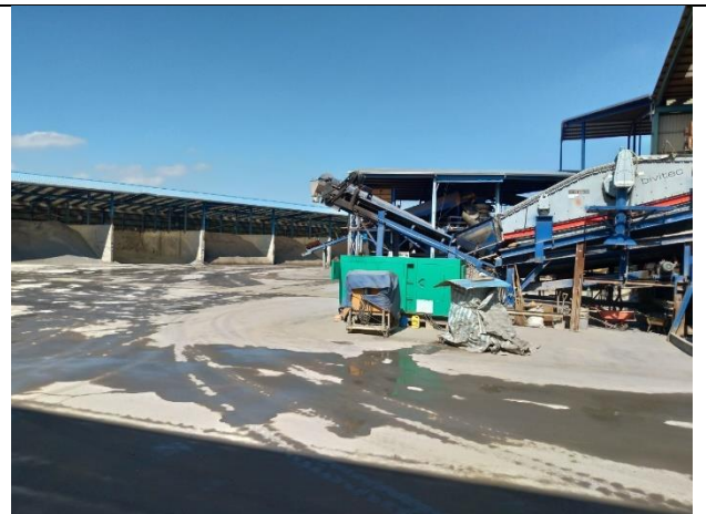
現場設備勘查
