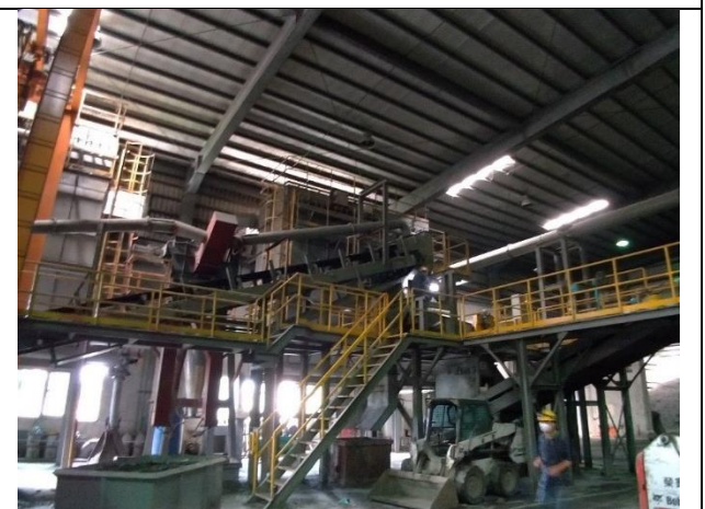
現場設備勘查
