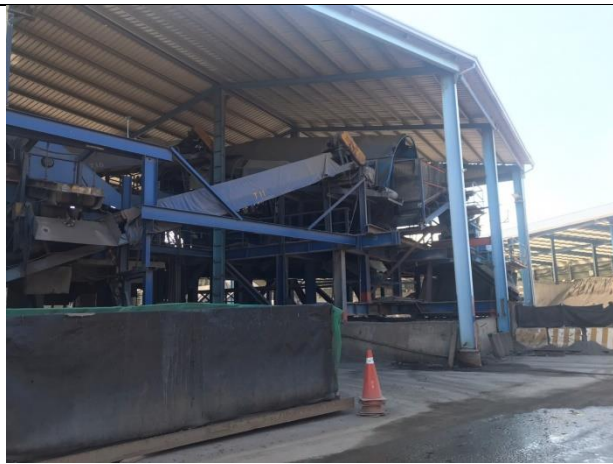
現場設備勘查
