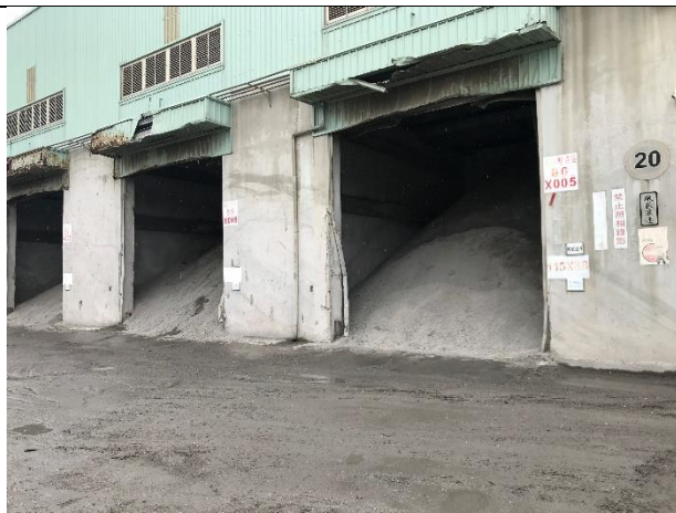
焚化再生粒料貯存區
