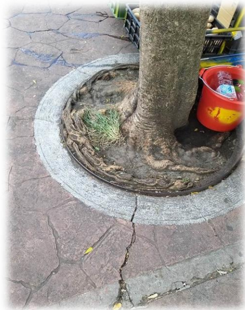
壓花地坪伸縮縫整條隆起不平 樹穴盤根情形嚴重，邊緣破裂隆起不平
