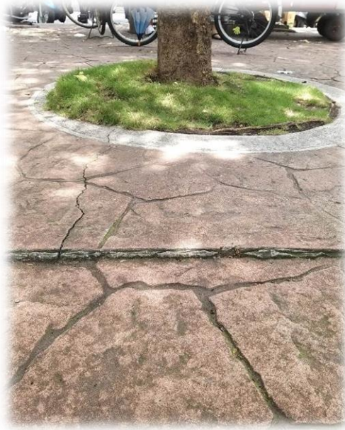
壓花地坪伸縮縫整條隆起不平 樹穴盤根情形嚴重，邊緣破裂隆起不平
