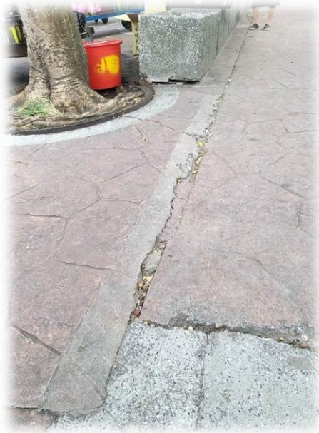
壓花地坪伸縮縫整條隆起不平 樹穴盤根情形嚴重，邊緣破裂隆起不平
