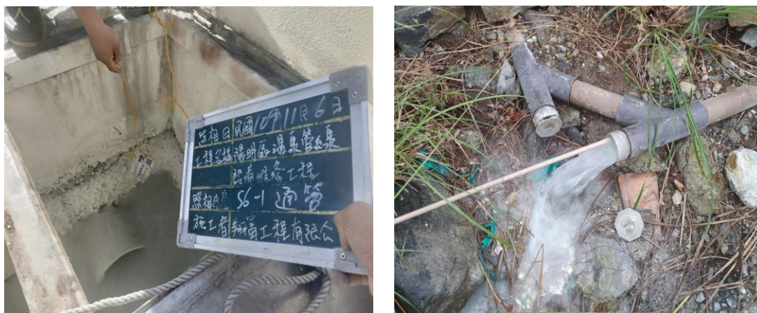
圖 3-4 溫泉設施短距離通管巡查及清理
