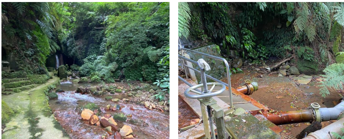
圖 3-2 上游泉源區取水口雜物清除
