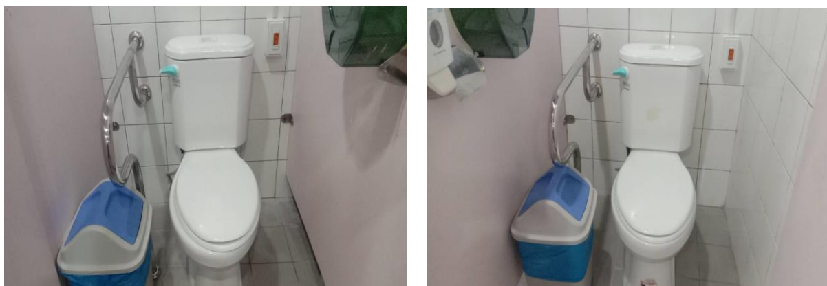
圖 3-16 地熱谷公廁安裝緊急安全警鈴及扶手
