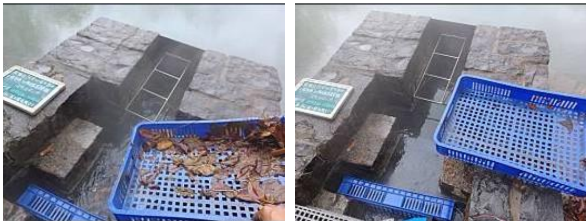
圖 3-5 地熱谷泉源區取水口雜物清理
