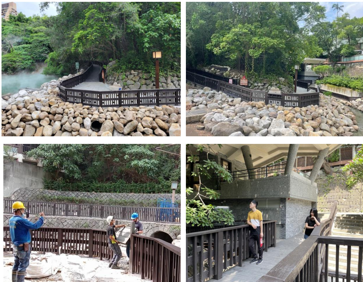
圖 3-15 地熱谷公園新設塑木橋及欄杆
