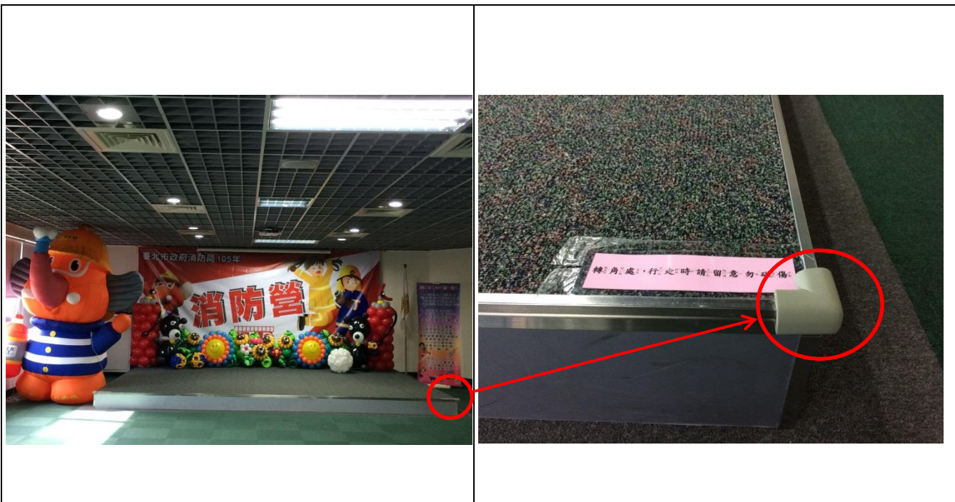
照片 1：舞臺轉角處加貼泡棉及加註警語，防止學童受傷。
