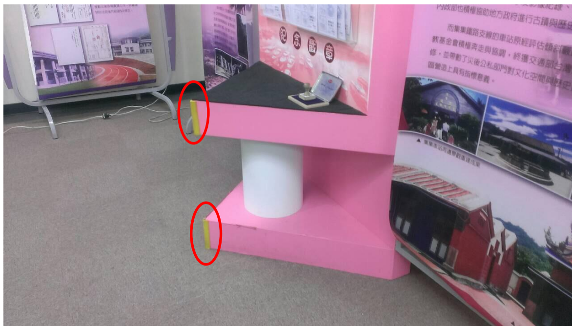
照片 2：活動區域內各設施設備有轉角處加貼泡棉，防止學童受傷。
