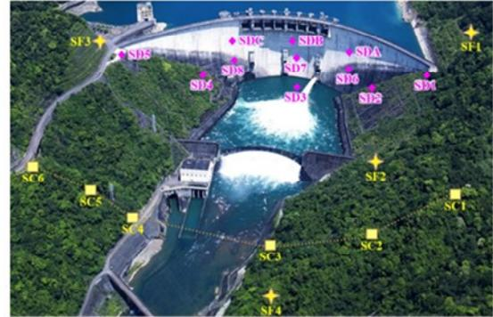
2套不同強震監測系統，以人工作業取得地震監測資料**每次需2小時以上**
