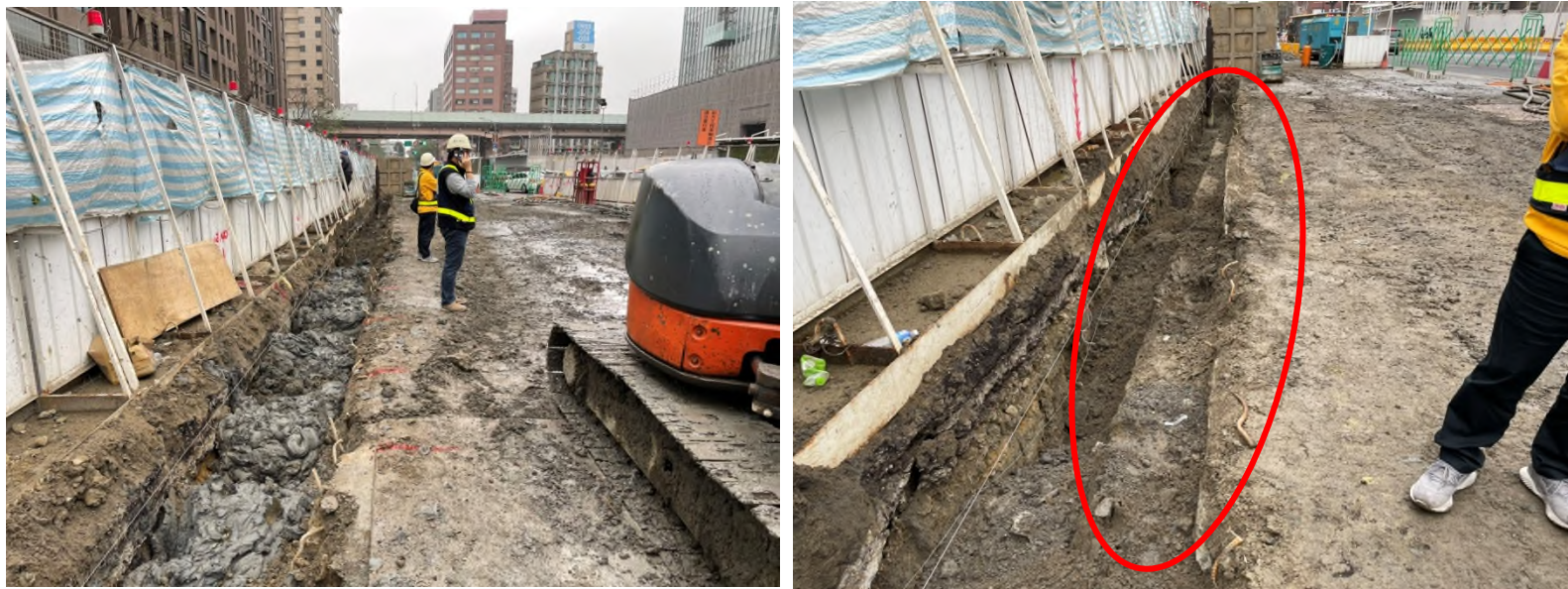
光復南路北側破碎遇障礙物
